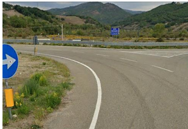
Int. . 6.3.1.1+6.3.1.2– Strada da piscina a Santa Filomena foto n°2
