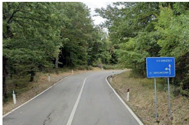
Int. 6.3.5.1+6.3.5.2-Strada confine Castelmezzano – SS.92 foto n°2
