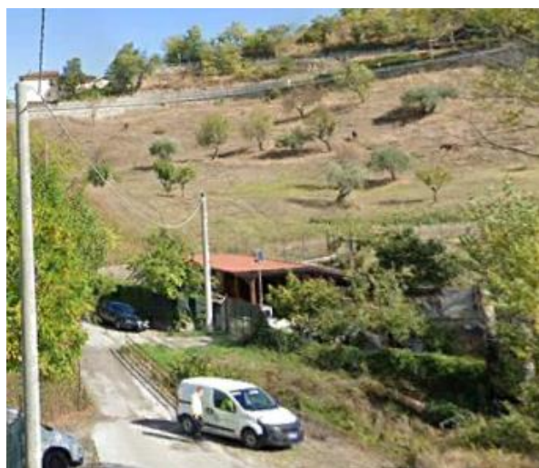
Int. 6.1.3- Torrente Coccone foto n°1
