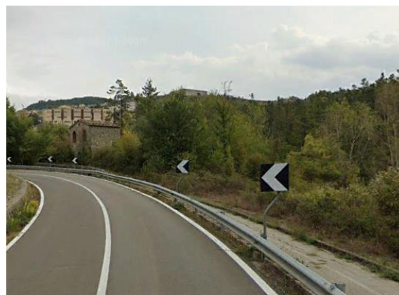
Int. 6.1.3- Torrente Coccone foto n°2
