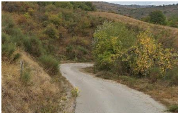
Int. 6.3.5.1+6.3.5.2- Strada confine Castelmezzano – SS.92 foto n°1
