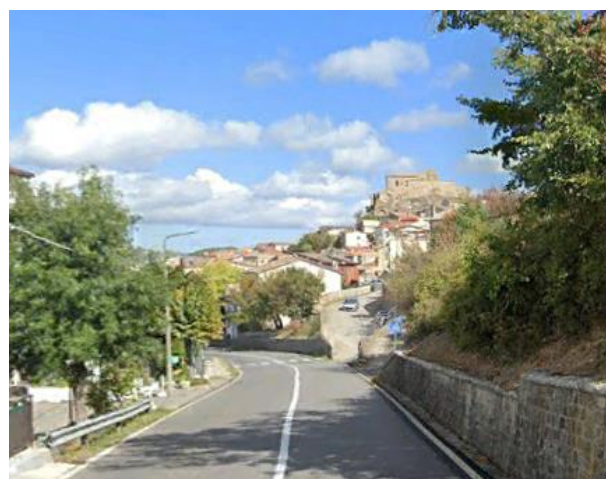
Int. 6.3.8.1+6.3.8.2- Strada centro abitato-torrente Coccone foto n°2
