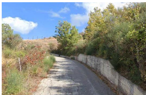
Int. 6.3.8.1+6.3.8.2- Strada centro abitato-torrente Coccone foto n°1
