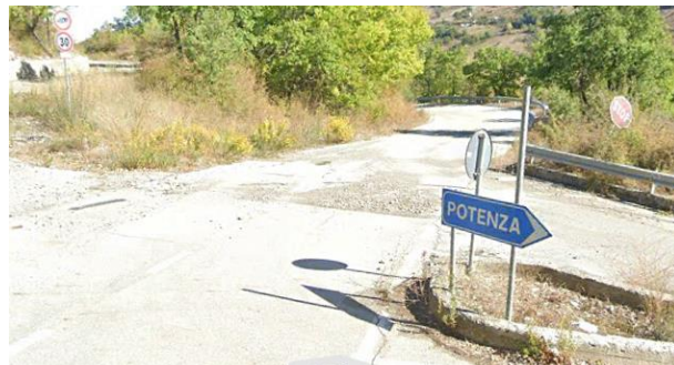
Int. 6.3.7.1+6.3.7.2 -Strada per Palazzo foto n°2
