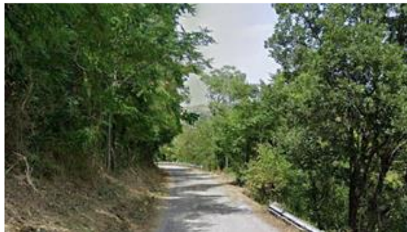
Int. 1.1.1 – 1° tratto fascia antincendio su SP Foto n° 1
