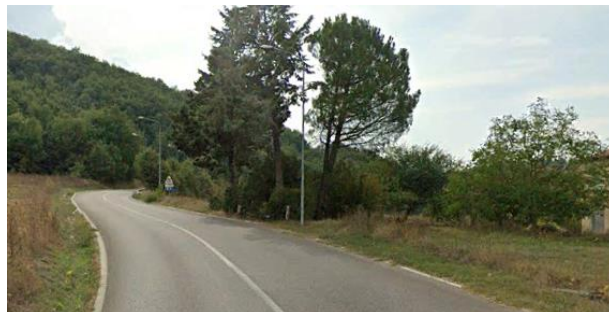
Int. 6.3.1.1+6.3.1.2- S.P.5 tratto nel territorio di Pignola Foto n°2
