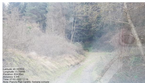
Int. . 6.3.14.1 +6.3.14.2 Strada per fontana comune Foto n° 1
