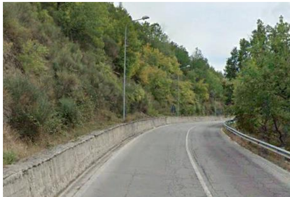
Int. 6.3.1.1+6.3.1.2- S.P.5 tratto nel territorio di Pignola Foto n°1
