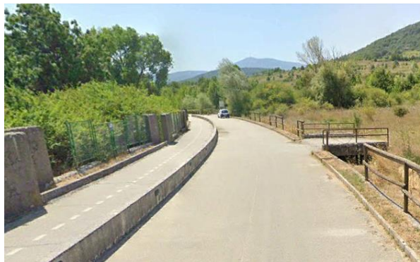
Int.2.1.7+2.2.7-Pista ciclopedonale Pignola-lago Foto n° 1
