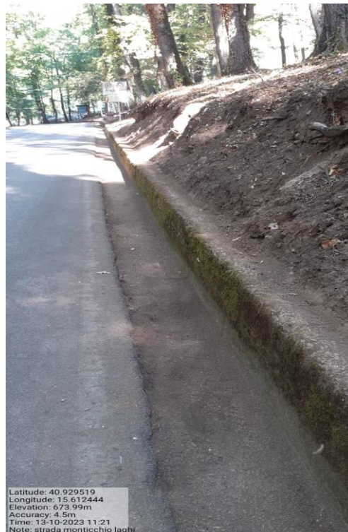
Int. 2 Loc. monticchio laghi – pulizia scarpata - ripristino staccionata
