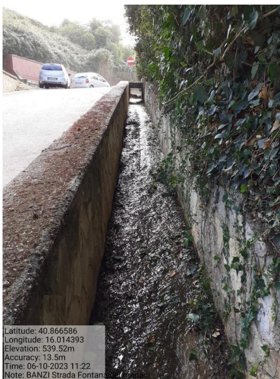
Int. 5 Loc. fontana monaci – pulizia canaletta di scolo
