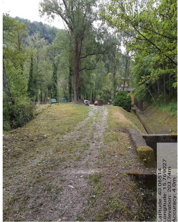
VASCA DI SOLLEVAMENTO LOC. FIUMICELLO - Foto 1
