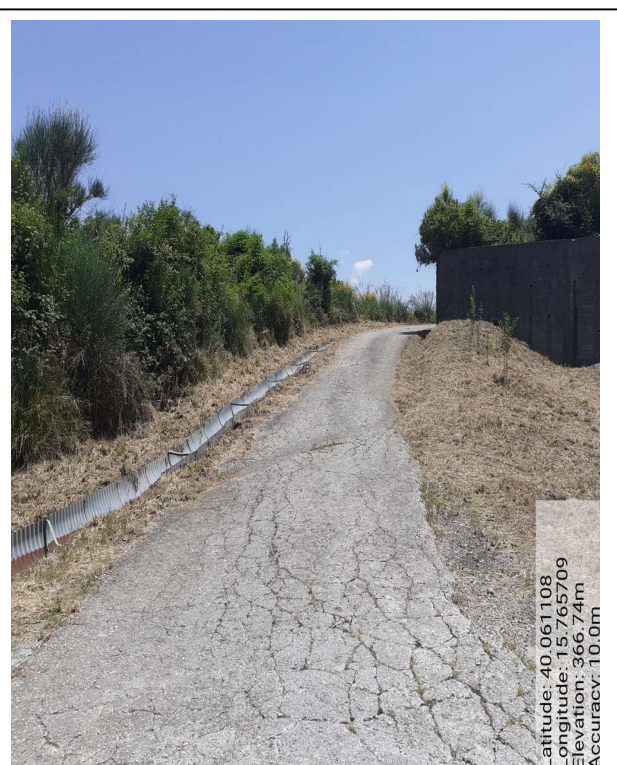
STRADA COMUNALE PRASTIOLI - Foto 1
