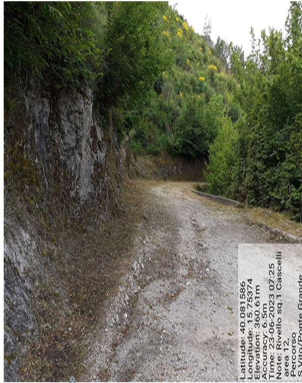
Fascia San Vito /ponte grande - Foto 1
