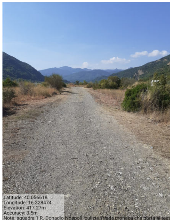
Int. _1.2._ Manutenzione Piste Foto 2
