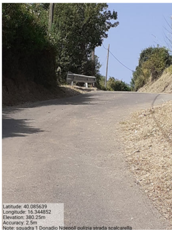
Int. _6.3._Manutenzione Strade Foto 1
