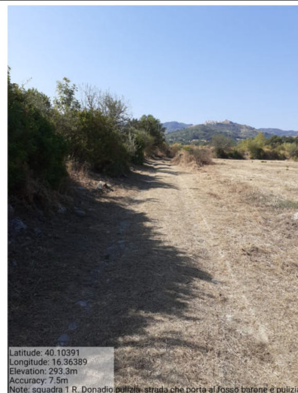
Int. _1.2._ Manutenzione Piste Foto 4
