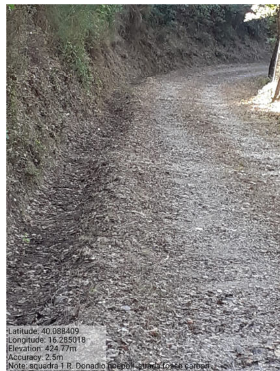
Int. _1.2._ Manutenzione Piste Foto 3
