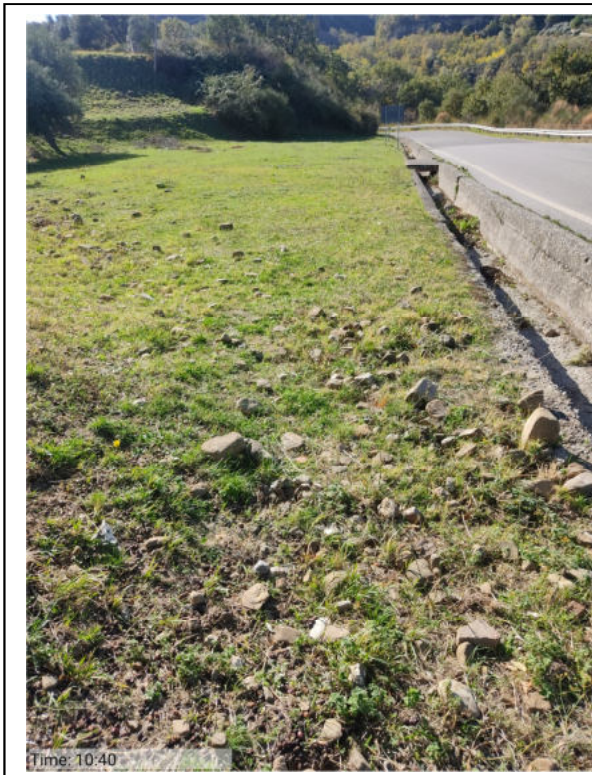
Int. _1.1.4_ Fascie Loc. Cimitero - Foto 1
