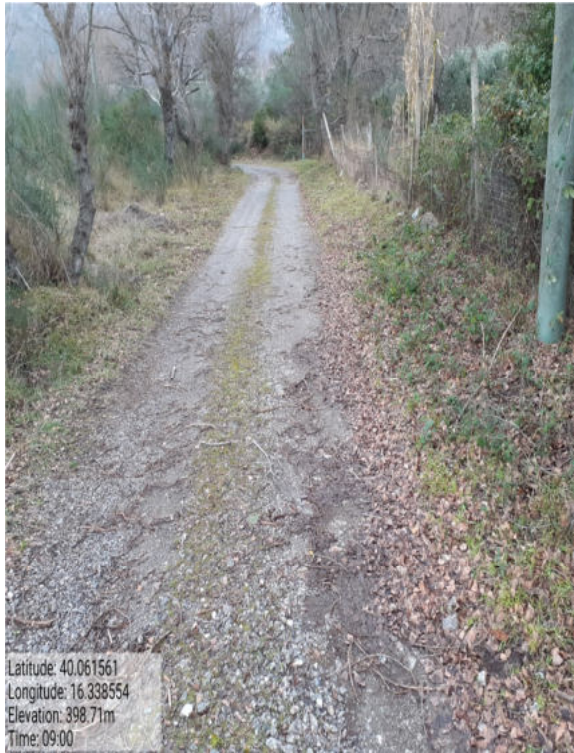
Int. _1.2_ Manutenzione Piste Foto 1
