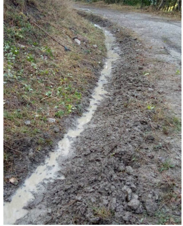
Int. _6.4_ Manutenzione Piste Foto 2
