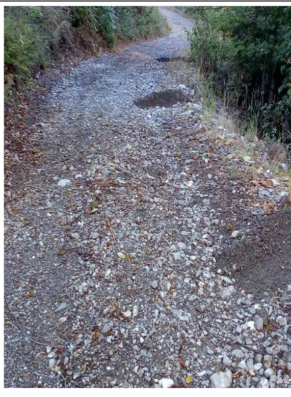
Int. _1.2._ Manutenzione Piste Foto 1
