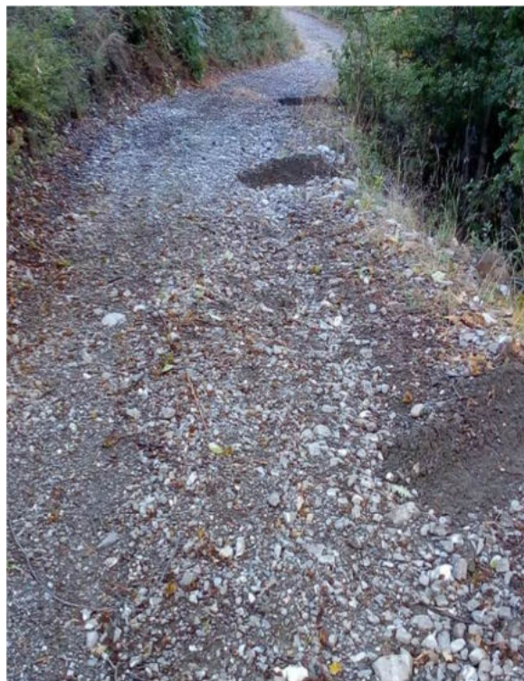
Int. _4.1._ Manutenzione Piste Foto 1
