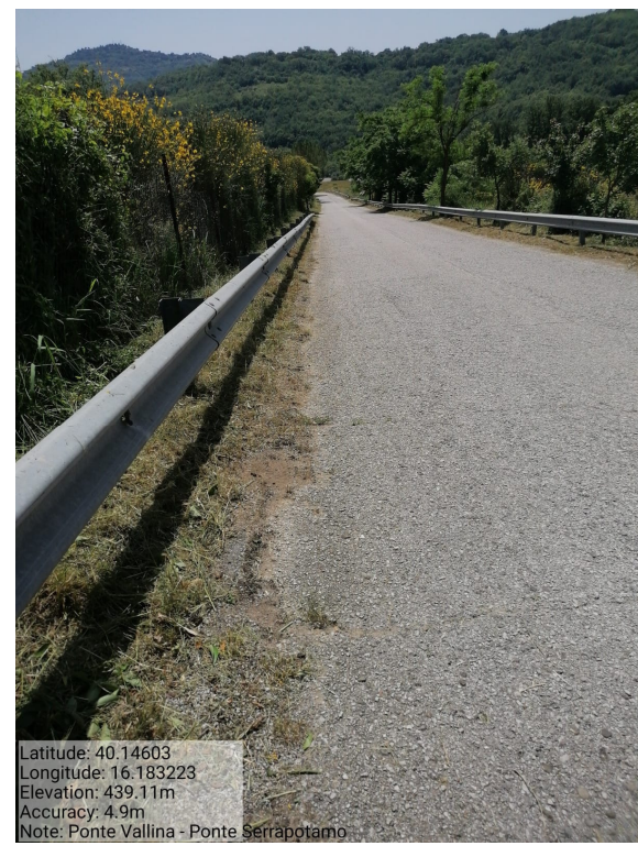
Int.6.3.14 - Ponte Vallina–Ponte Serrapotamo - Foto 1
