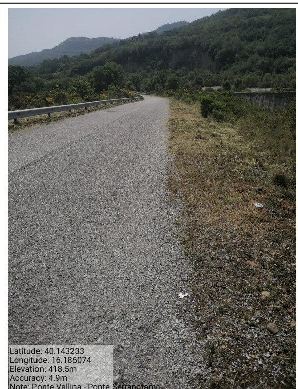
Int.6.3.14 - Ponte Vallina–Ponte Serrapotamo - Foto 2
