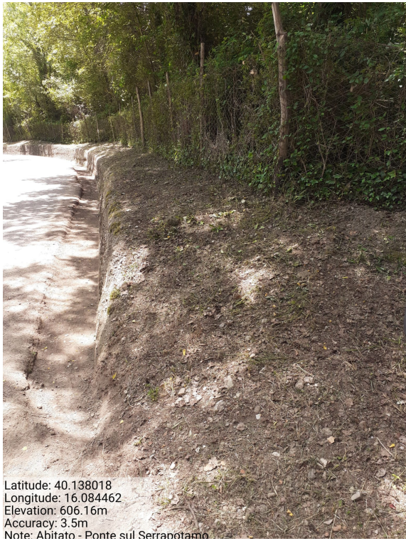
Int.6.3.4.1-Abitato – Ponte sul Serrapotamo - Foto 1
