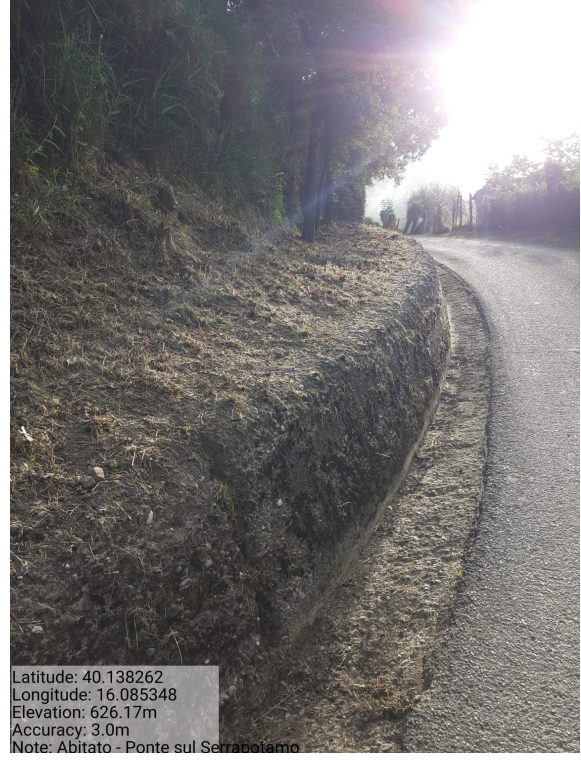
Int.6.3.4.1-Abitato – Ponte sul Serrapotamo - Foto 2
