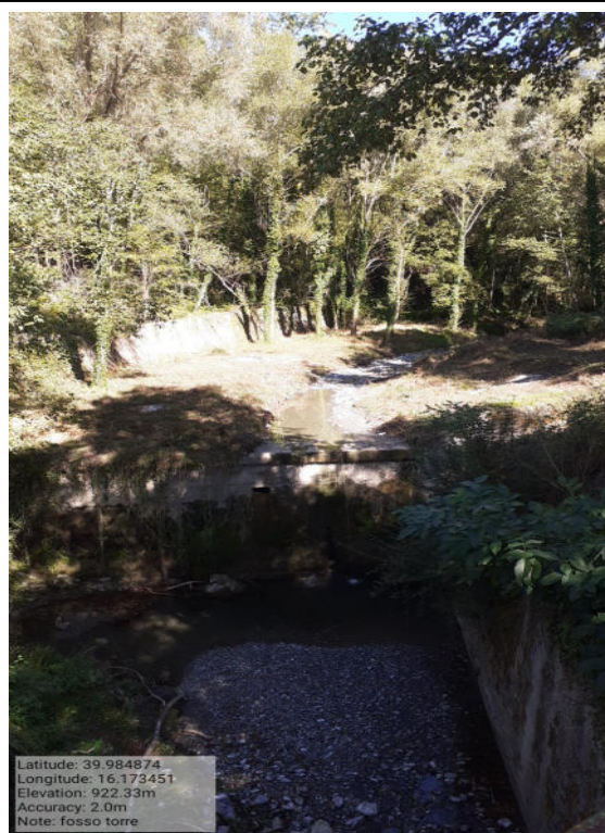
Int. 6.1.11 Loc. fosso Torre- Foto 2
