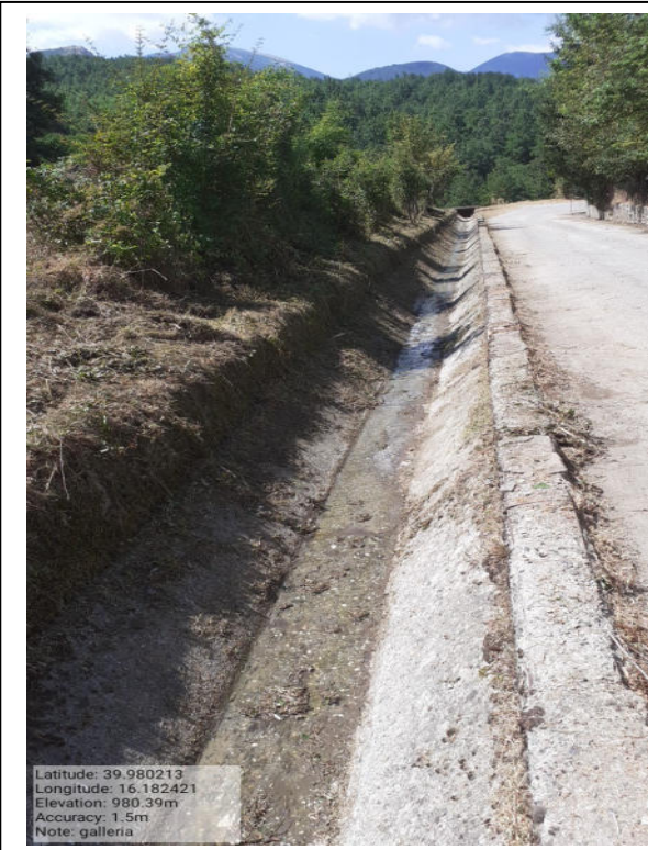
Int. 6.2.3 Loc. Mezzana – Foto 1
