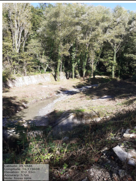
Int. 6.1.11 Loc. fosso Torre – Foto 1
