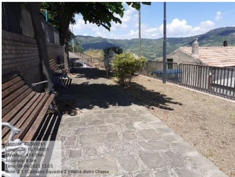
INTERVENTO 2.1.1 CALCIANO VERDE URBANO (3) DOPO FOTO 15
