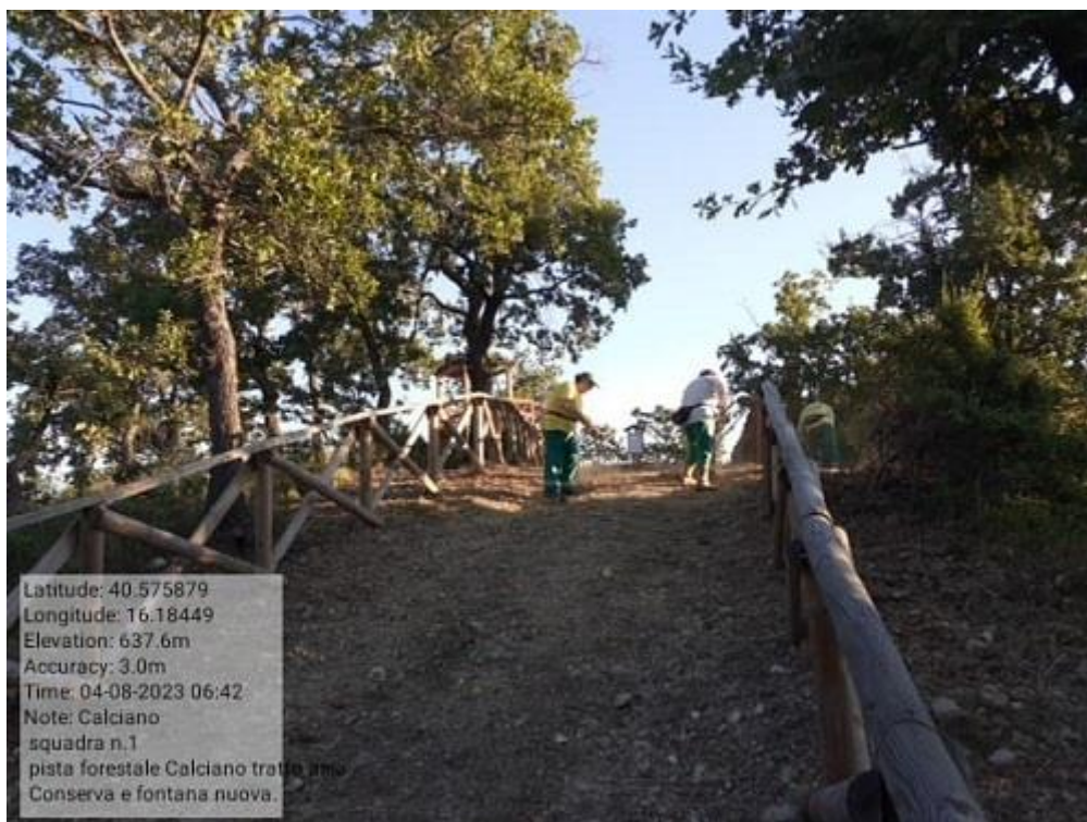
INTERVENTO 1.1.7 CALCIANO FG 9 PART 33 LOC VIGNALI
