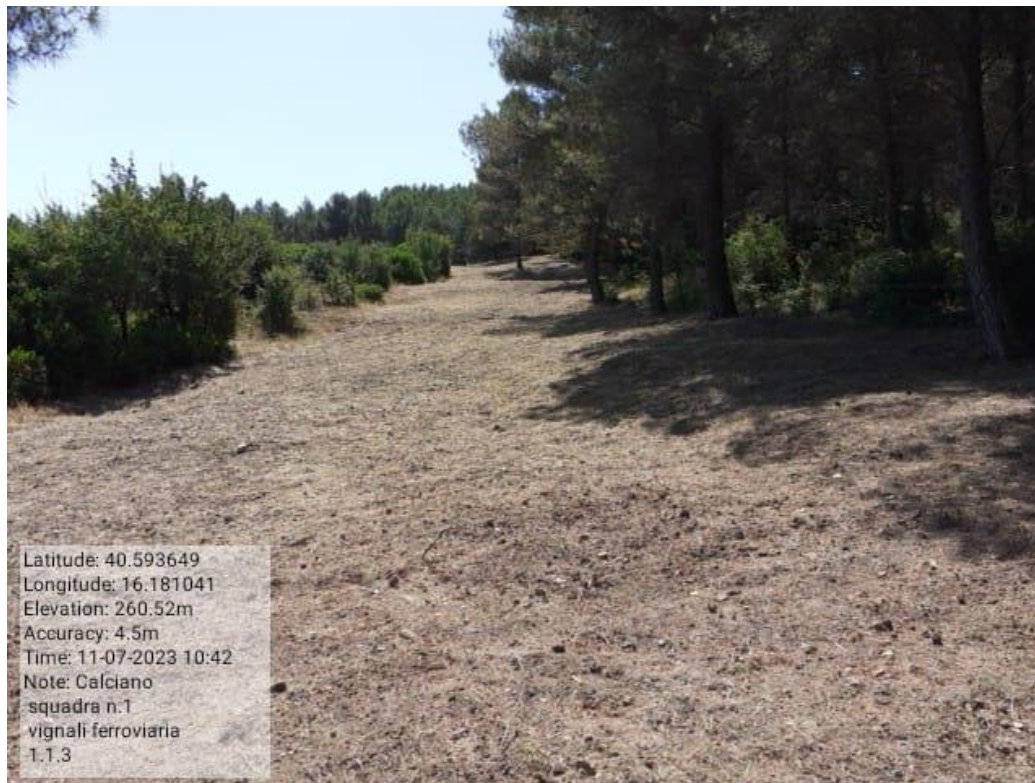
INTERVENTO 1.1.3 CALCIANO FG 9 PART 33-32-9 LOC. VIGNALI FERROVIA DOPO FOTO 3
