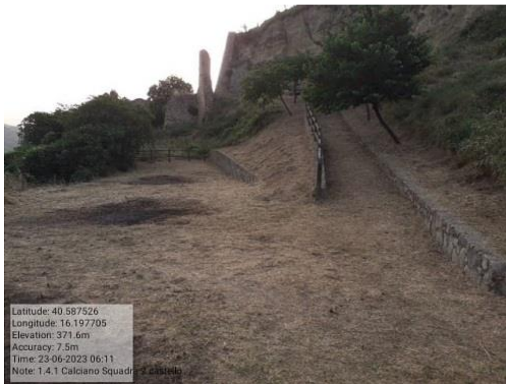
INTERVENTO 1.4.1 CALCIANO AREA CASTELLO DOPO
