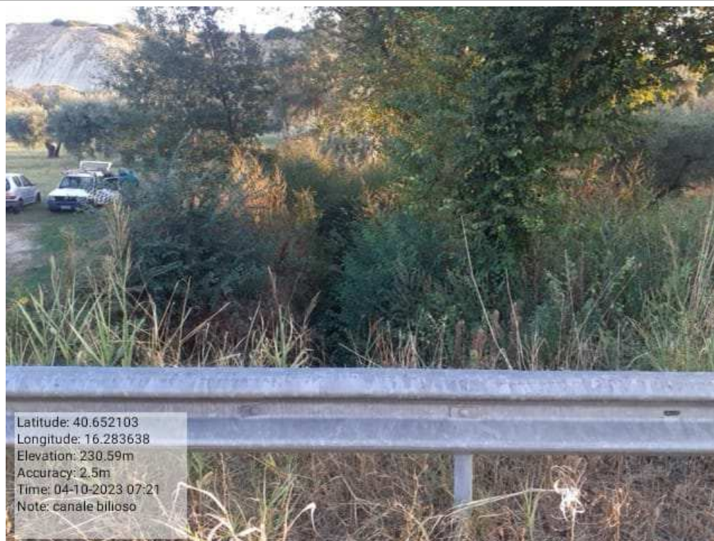
INTERVENTO 6.1.2.1 Grassano Fg.4 Fosso Tilea 2 prima Foto n.56
