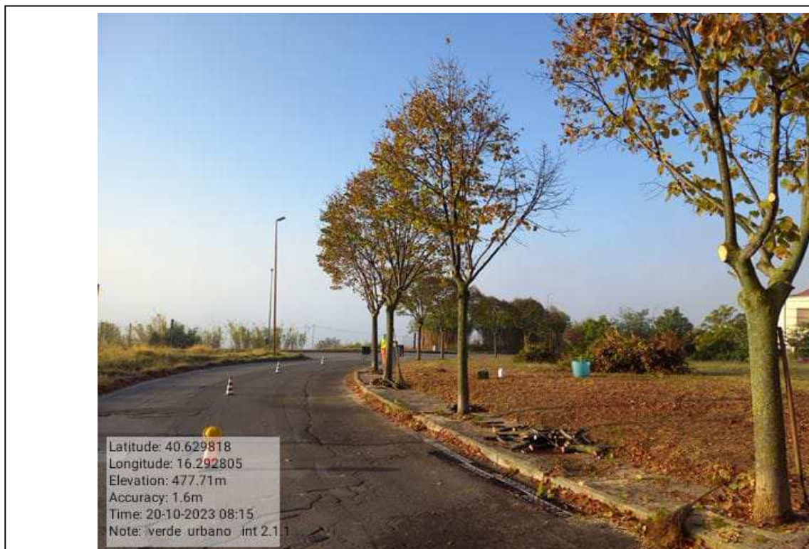
INTERVENTO 2.1.1 Grassano VEDE URBANO Via Aldo Moro – Spalcatura Alberi - DURANTE Foto n.68
