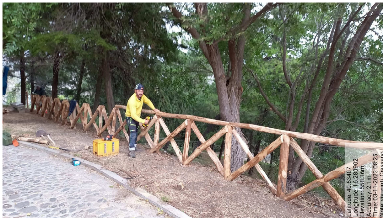
INTERVENTO 6.4.3.1 Grassano Fg.12 part.103 Zona Cinti DURANTE Foto n. 80
