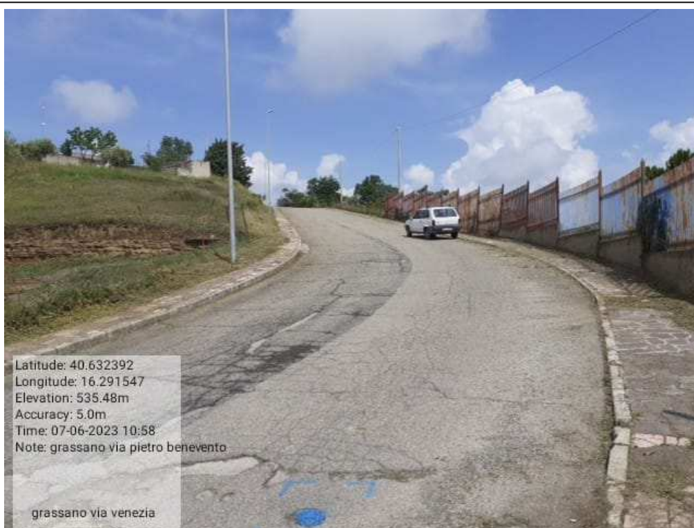
INTERVENTO 2.1.1 vede urbano – Via Aldo Moro zona Serbatoio Foto n. 18
