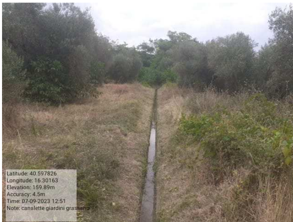
INTERVENTO 6.1.7.2 Grassano Fg.31 Canaletta Irrigazione - Distribuzione Principale Distretto 3 (tratto B) DOPO Foto n. 49
