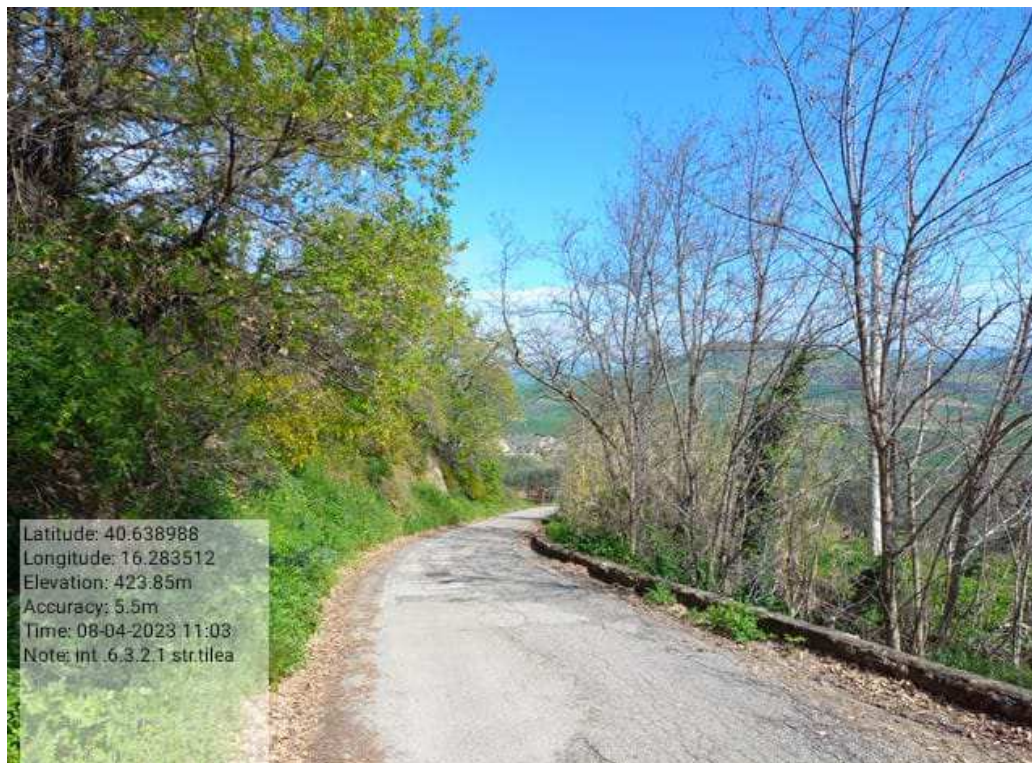
INTERVENTO 6.3.2.1 Grassano Fg.6-4 strada Comunale Tilea Prima Foto n. 23
