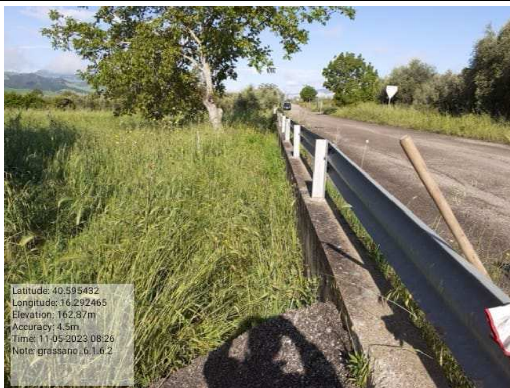
INTERVENTO 6.1.6.2. Grassano Fg.28-29-26-30-31 Canaletta Irrigazione - Distribuzione Principale Distretto 3 (tratto A) PRIMA Foto n. 45
