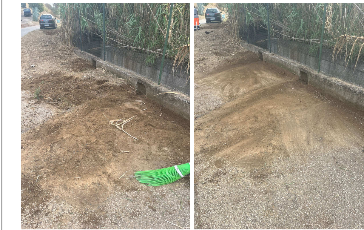
INTERVENTO 6.3.9.1 Grassano Fg.17 Trattuto Grassano Grottole secondo tratto- Durante e dopo Foto n. 73
