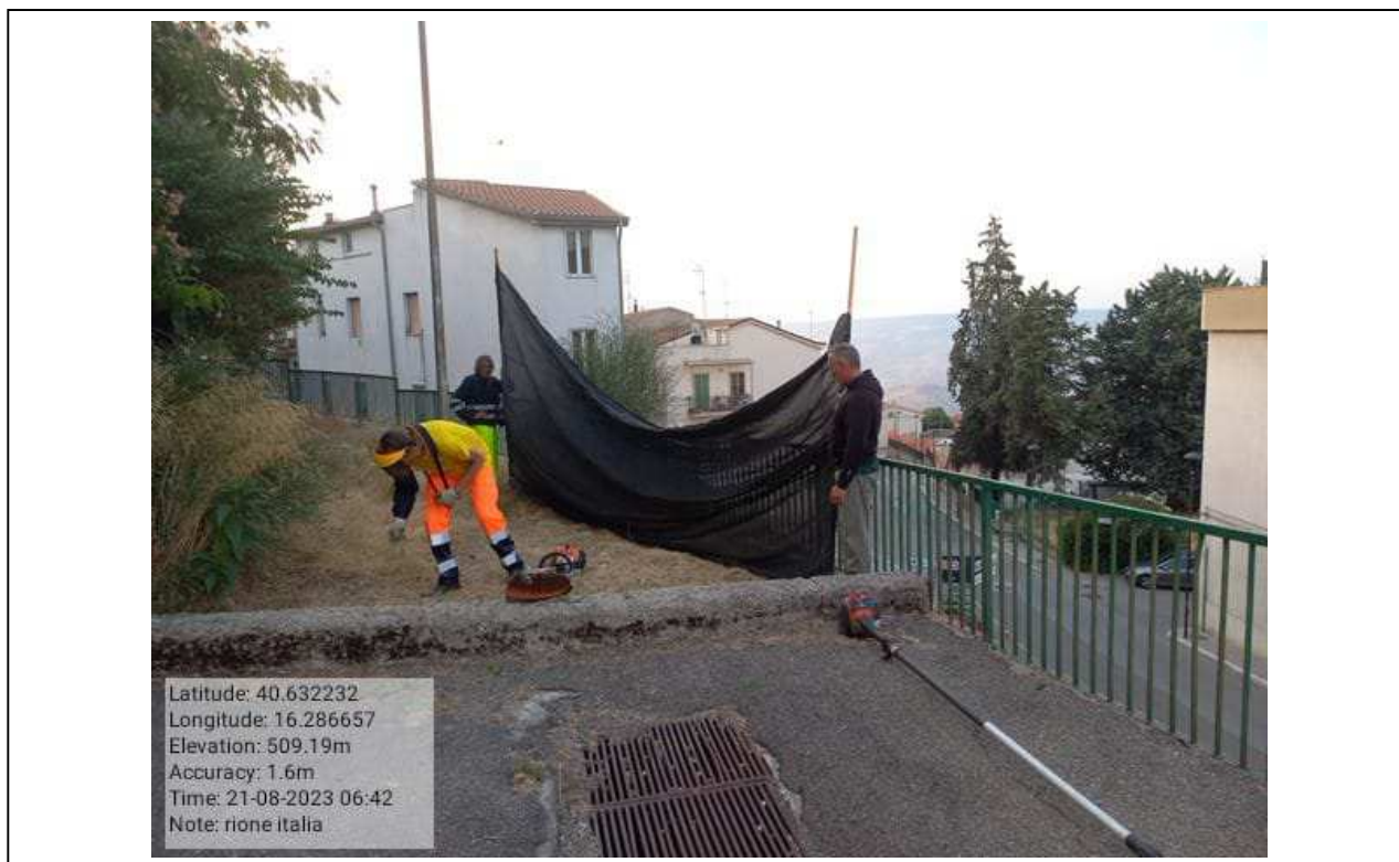
INTERVENTO 2.1.1 Grassano Verde Urbano – Rione Italia DURANTE
