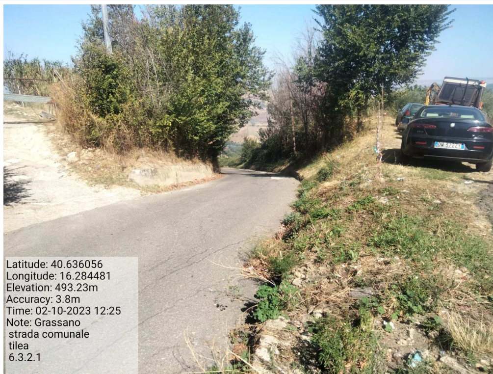
INTERVENTO 6.3.2.1 Grassano Fg.6-4 strada Comunale Tilea Dopo Foto n. 24
