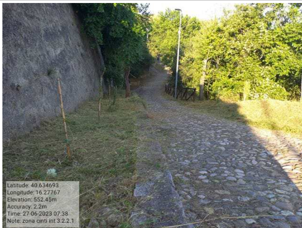
INT. 1.2.3 Grassano Fg.12 Part. 103-1302- Strada comunale Cinti - Perimetro cinti –DOPO Foto n. 35
