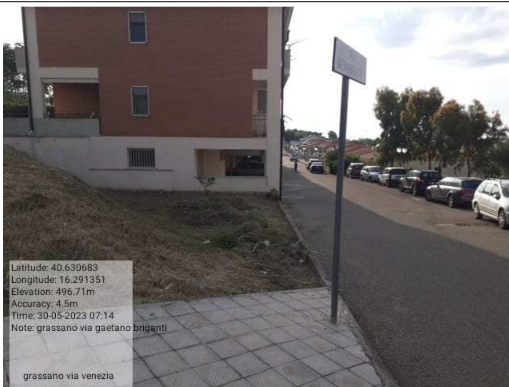
INTERVENTO 2.1.1 Grassano Vico 1° Briganti PRIMA Foto n. 28
