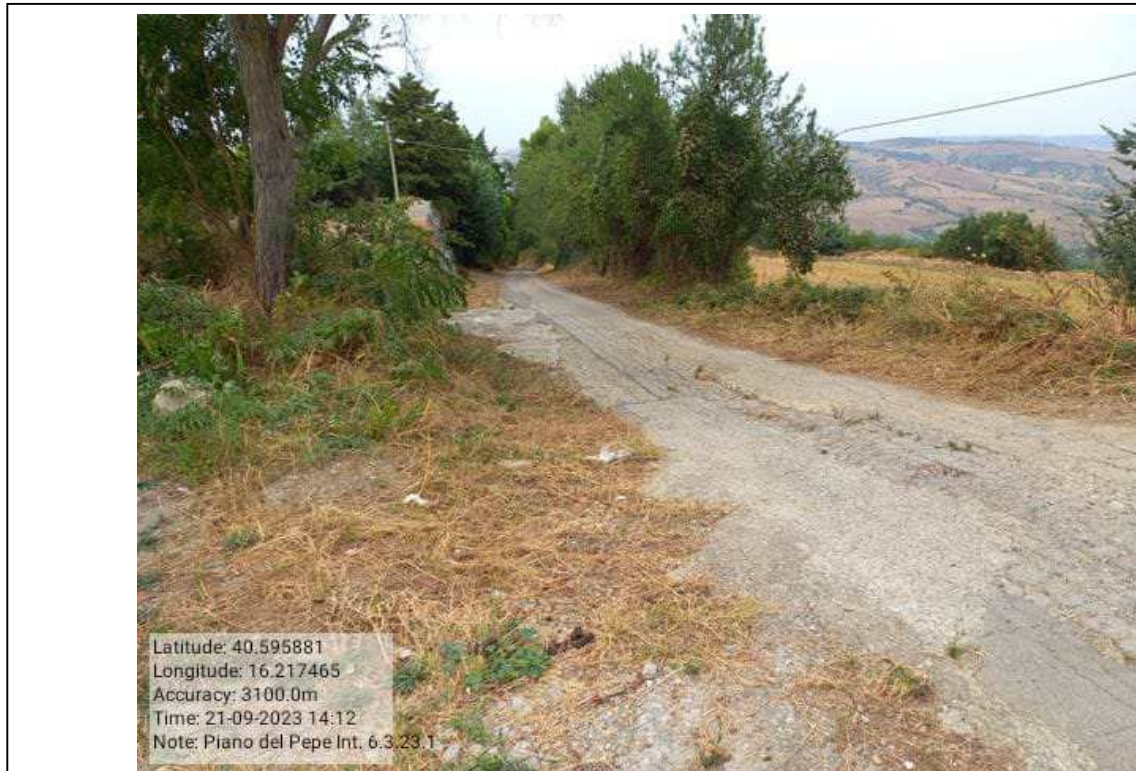
INTERVENTO 6.3.23.1 Grassano Fg.11 Part. Strade Fg.3 Strade STR. Com. Piano del Pepe DOPO Foto n.63
