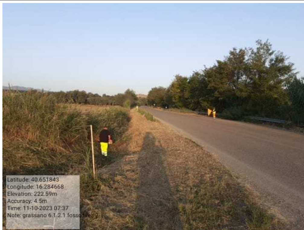
INTERVENTO 6.1.2.1 Grassano Fg.4 Fosso Tilea 2 DURANTE Foto n.57
