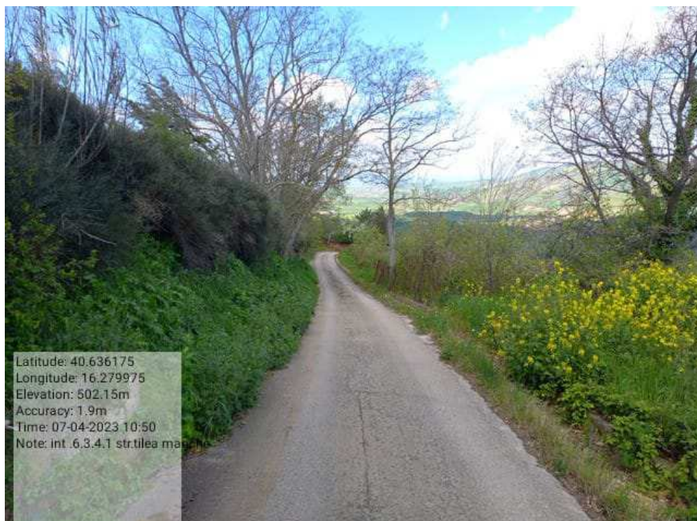
INTERVENTO 6.3.4.1 Grassano Fg.6 Strada Comunale Tilea - Manche PRIMA Foto n31
