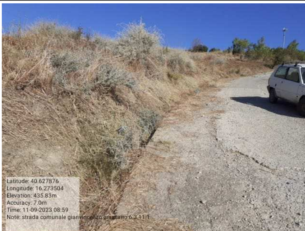
INTERVENTO 6.3.11.1 Grassano fg 11 15STRADA COMUNALE GIANVINCENZO DURANTE Foto n. 60
