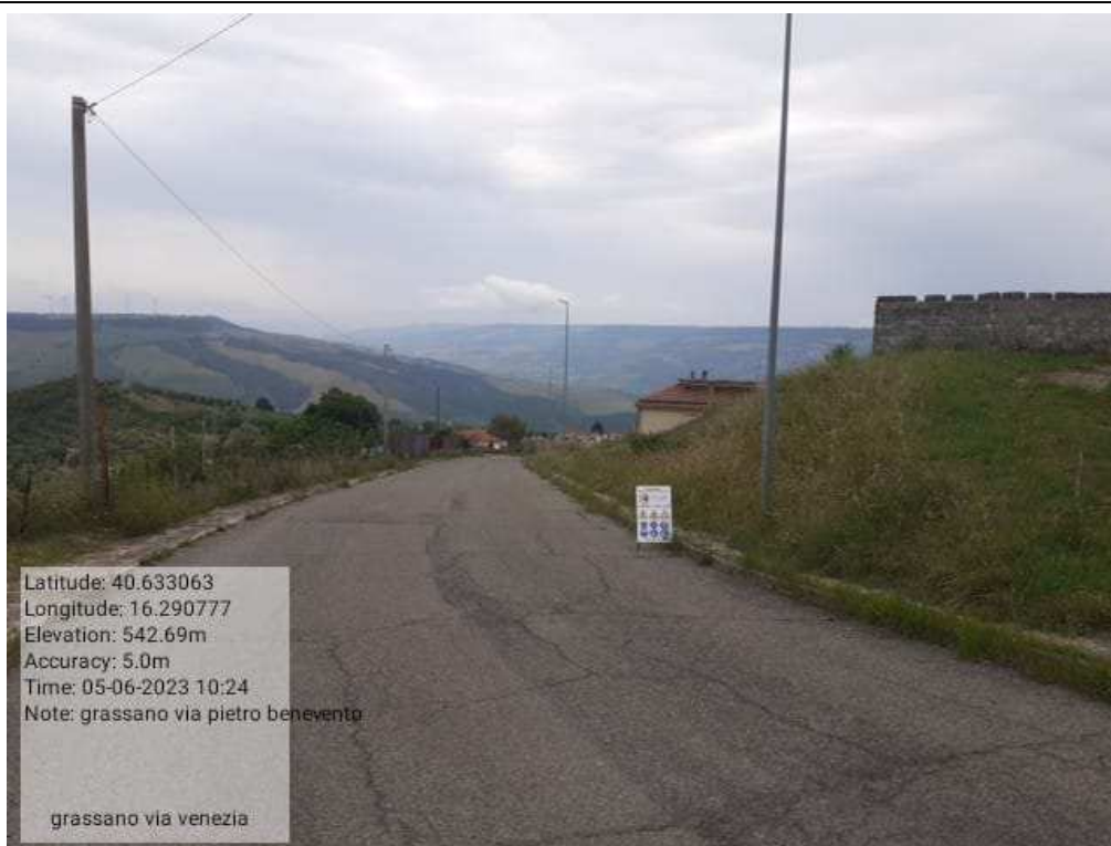
INTERVENTO 2.1.1 vede urbano – Via Aldo Moro zona Serbatoio Prima - Foto n.17
