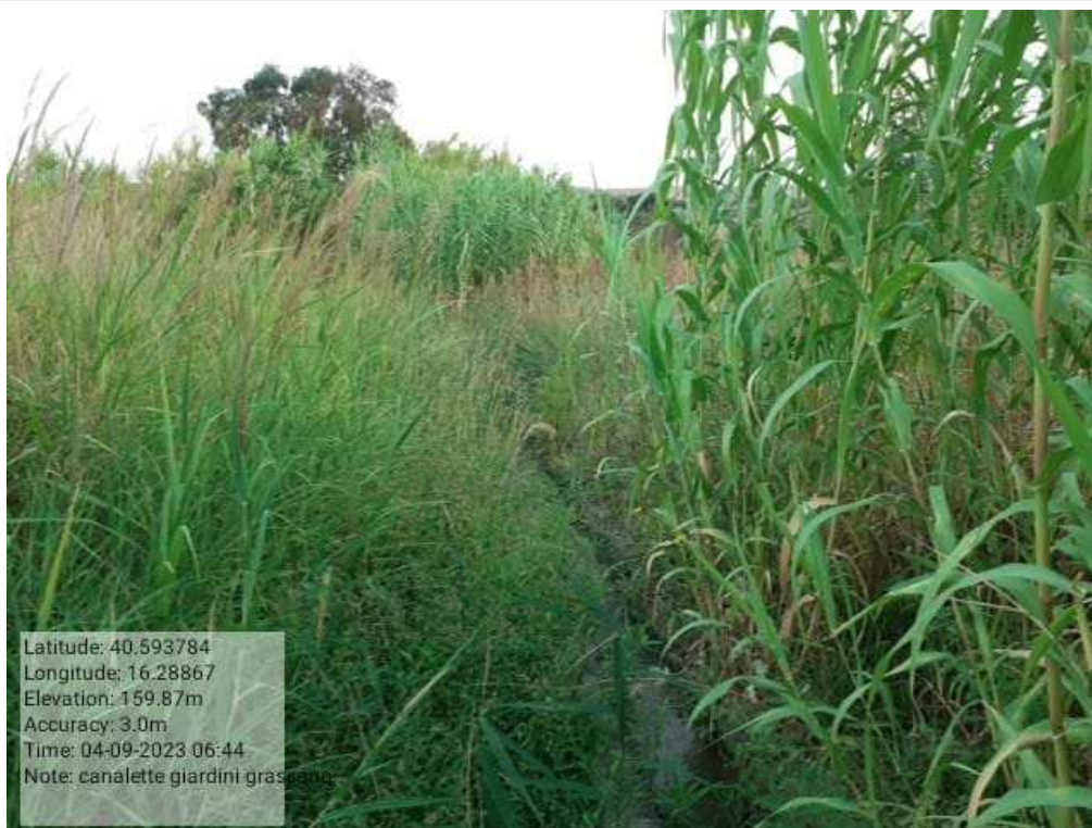
INTERVENTO 6.1.8.2 Grassano Fg.26-30 Canaletta Irrigazione - Distribuzione Principale Distretto 3 (tratto B) PRIMA - Foto n. 50
