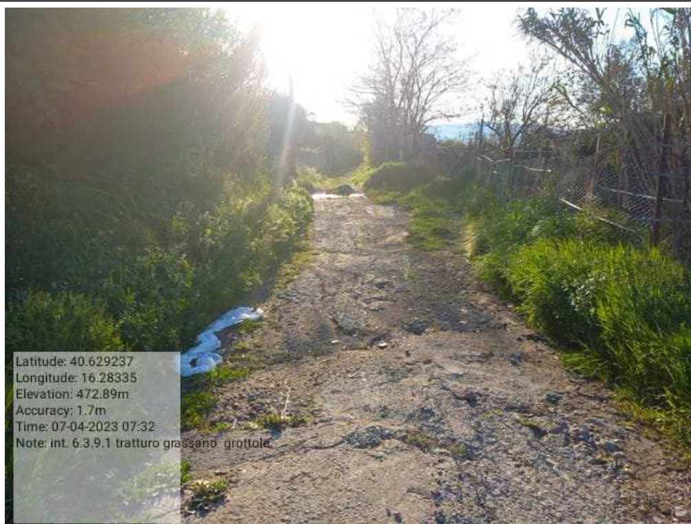
INTERVENTO 6.3.9.1 Grassano Fg.17 Tratturo Grassano Grottole secondo tratto PRIMA Foto n. 70
