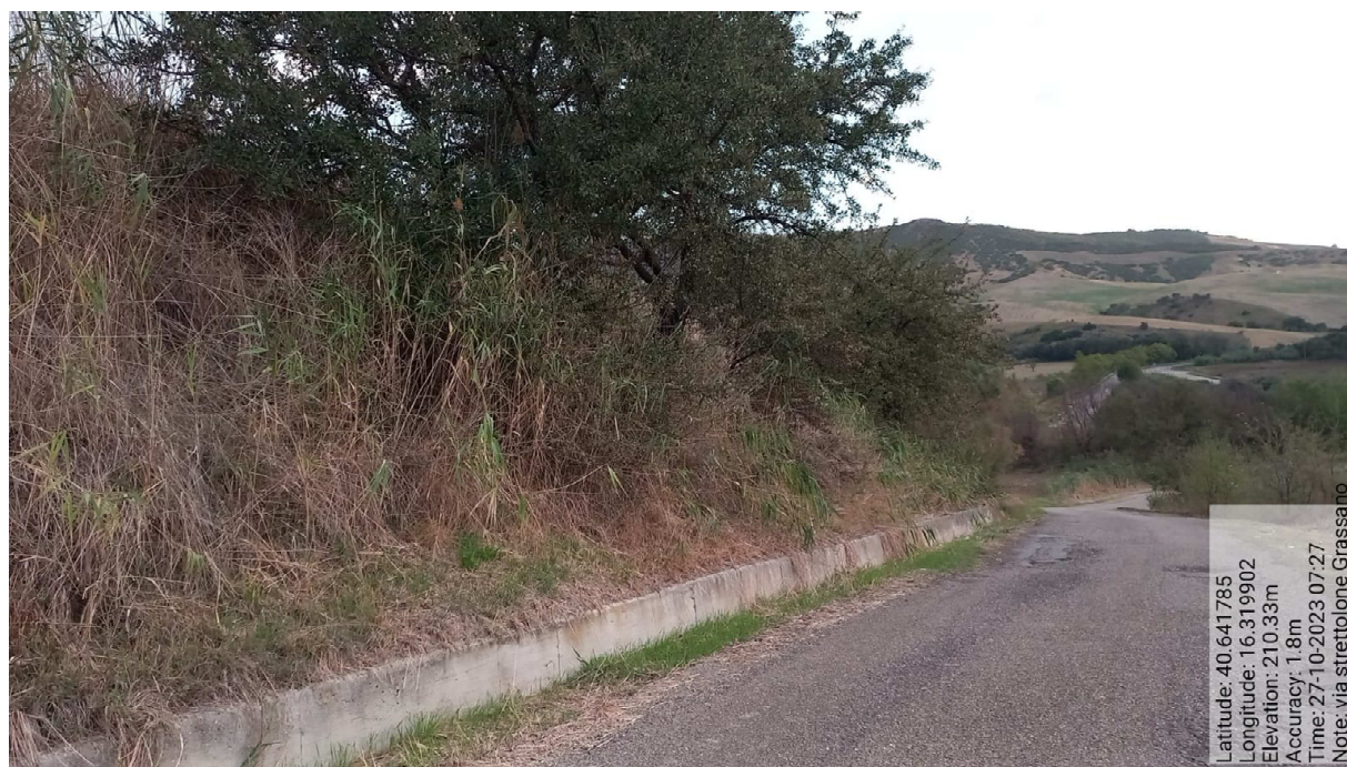
INTERVENTO 6.3.1.2 Grassano Fg.13-7-14 Strada Comunale Strettolone PRIMA Foto n. 64
