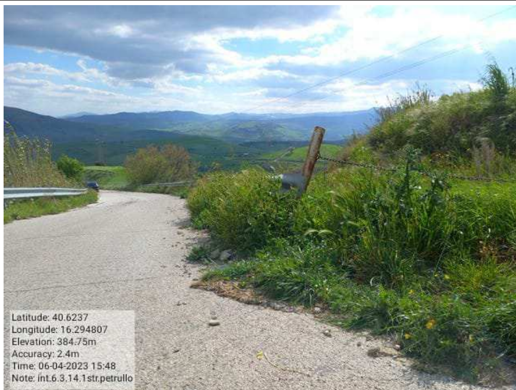
INTERVENTO 6.3.14.1 Grassano Fg.31-27-23-16-17 Strada Comunale Petrullo- PRIMA Foto n. 77
