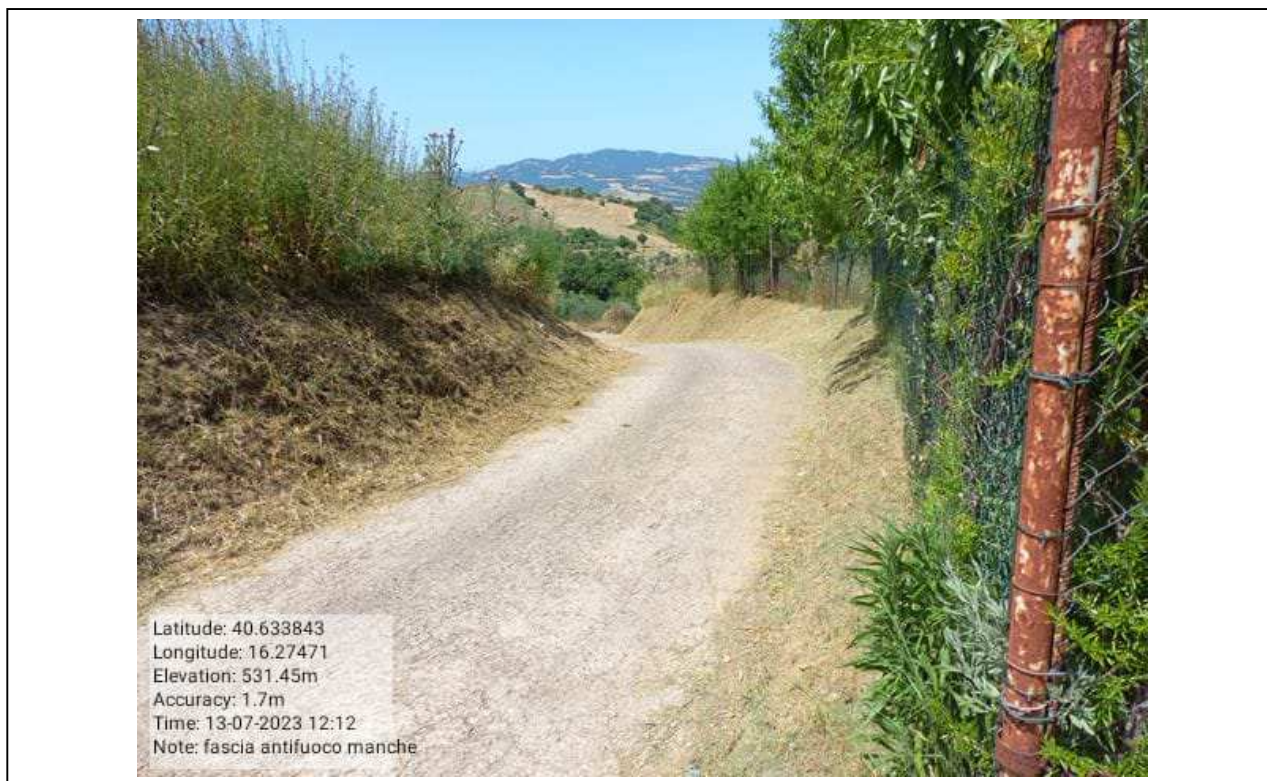
INT. 4.2.3 Grassano Fg.6 Strada Vicinale Fontanelle- DOPO Foto n. 38
