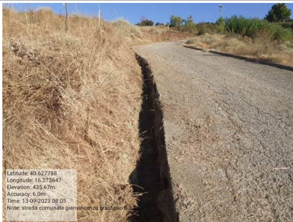
INTERVENTO 6.3.11.1 Grassano fg 11 15STRADA COMUNALE GIANVINCENZO DOPO Foto n. 61
