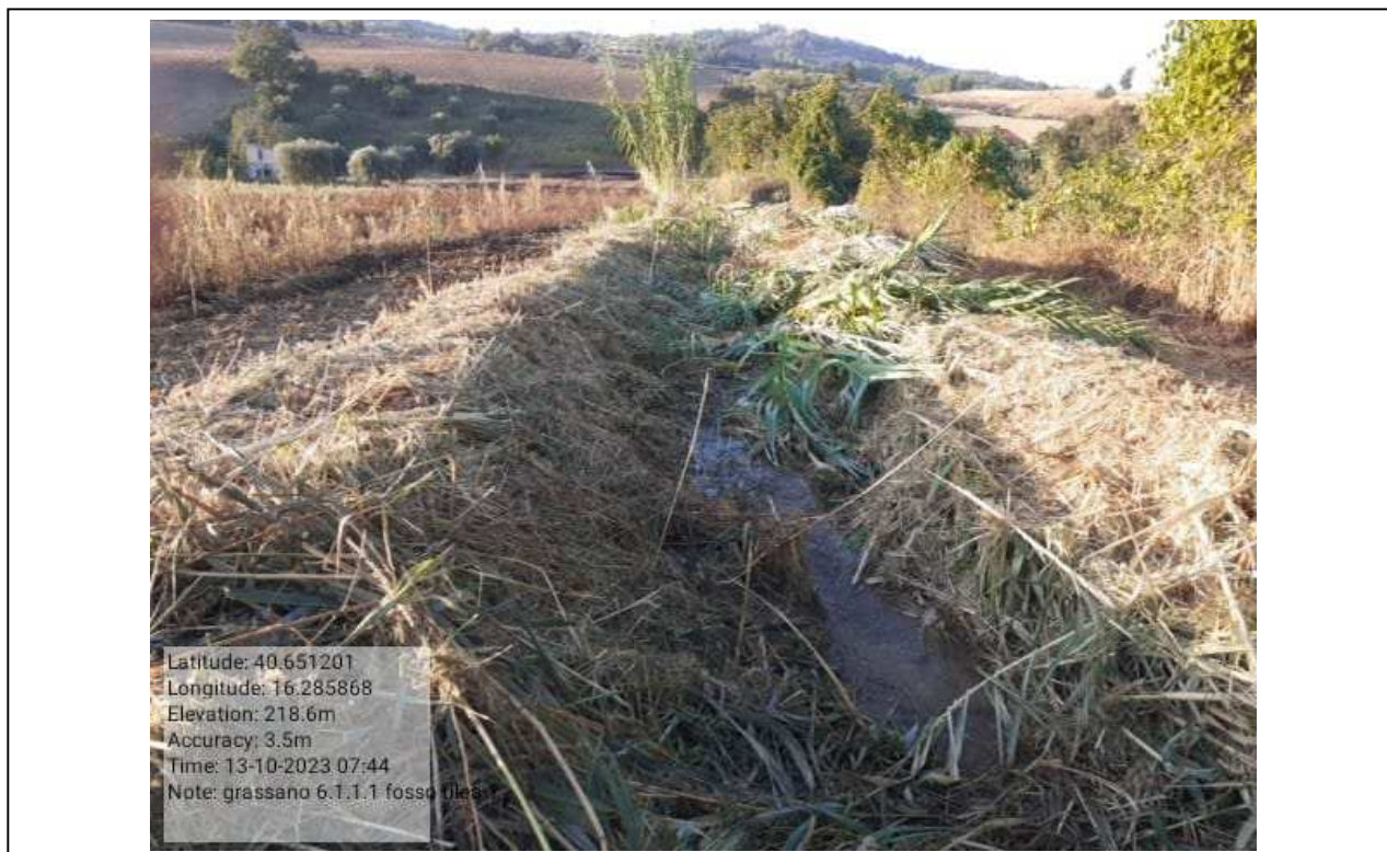
INTERVENTO 6.1.1.1 Grassano Fg.4 Fosso Tilea 1 Durante Foto n.54
