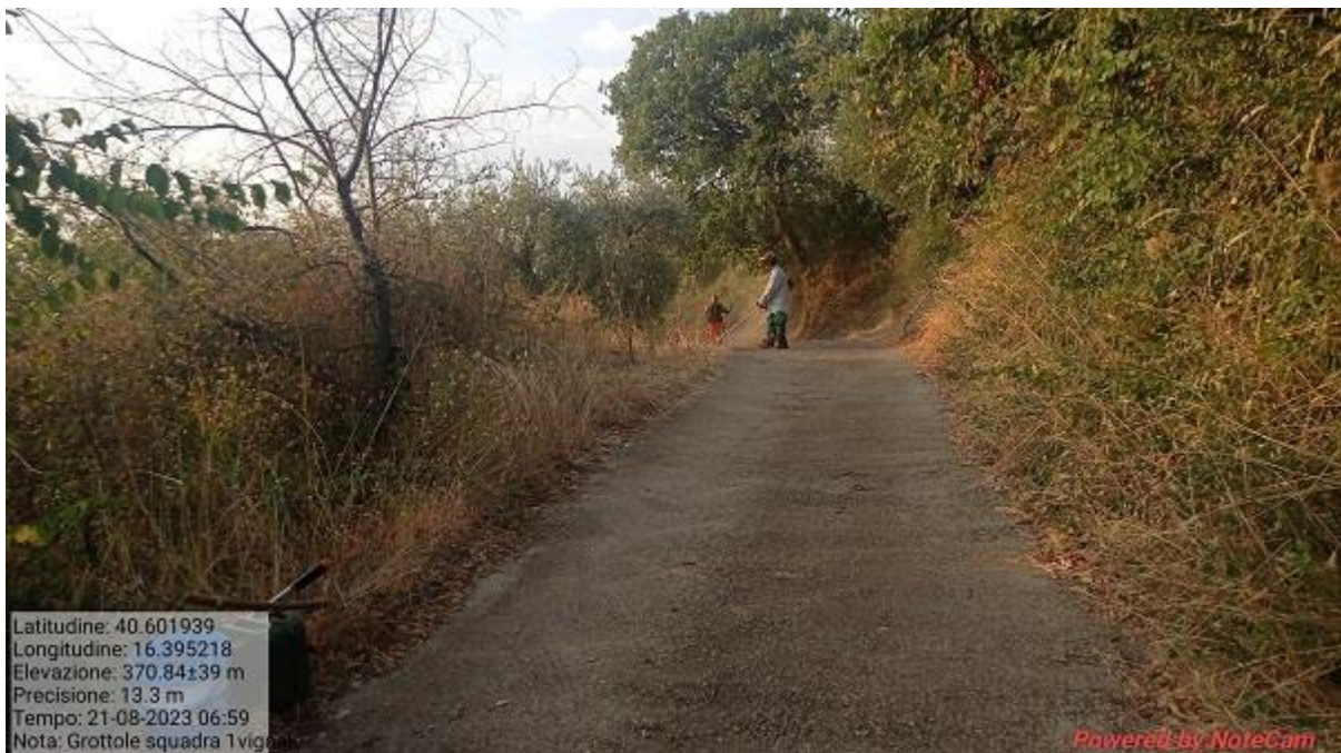
INTERVENTO 6.3.6.1 GROTTOLE STRADA COMUNALE VIGNALI FG 40
