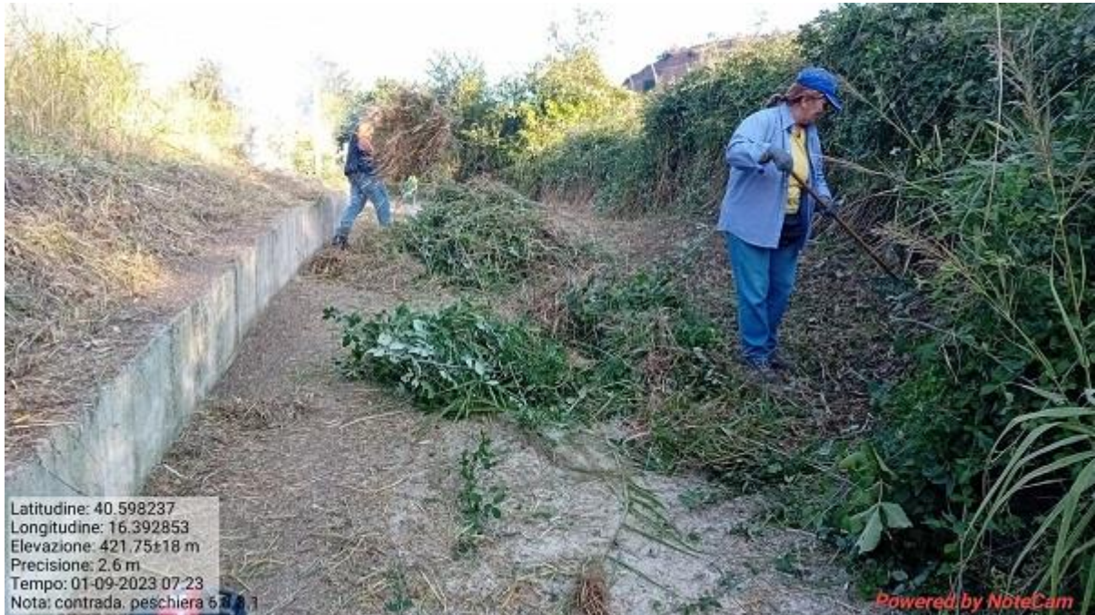
INTERVENTO 6.3.8.1 GROTTOLE STRADA COMUNALE PESCHIERA FG 50
