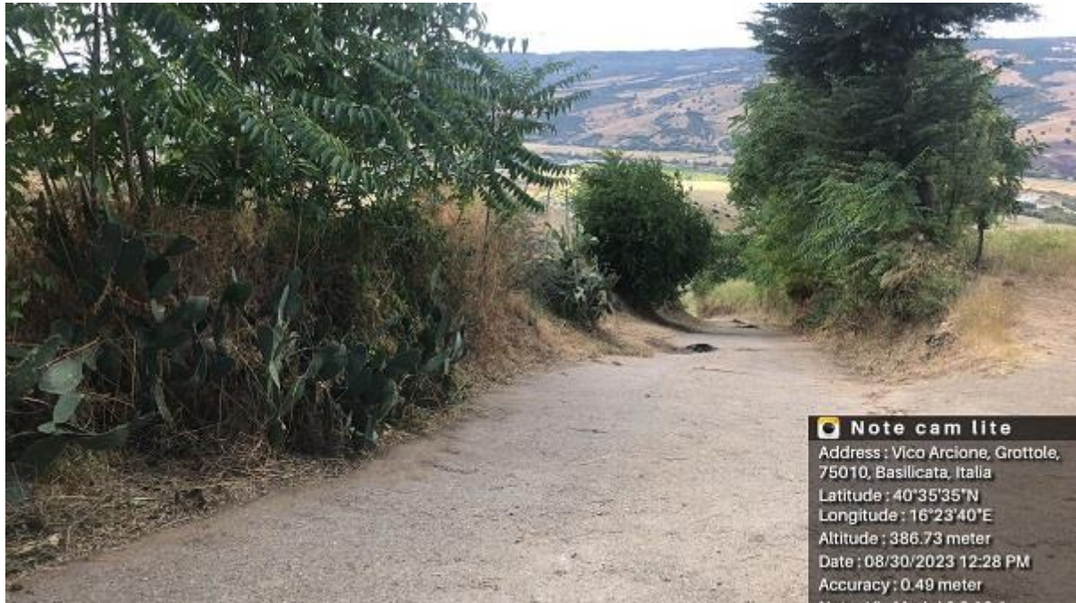
INTERVENTO GROTTOLE STRADA COMUNALE ARICIONE - VEDE PRIURBANO
