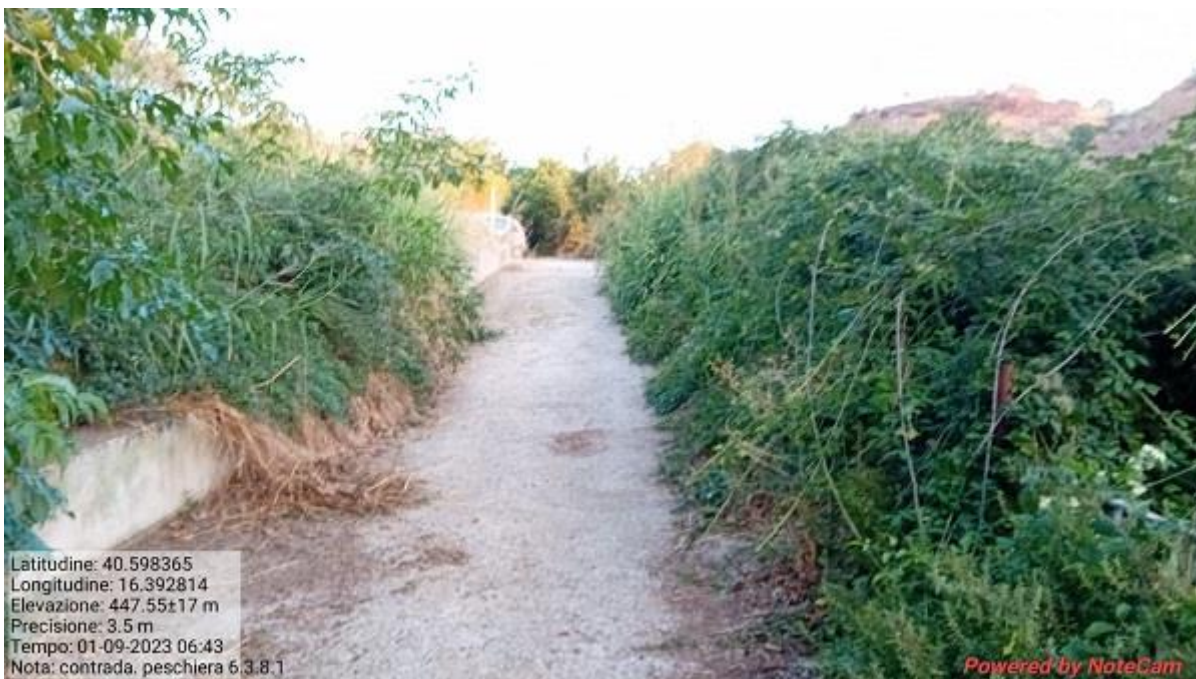
INTERVENTO 6.3.8.1 GROTTOLE STRADA COMUNALE PESCHIERA FG 50
