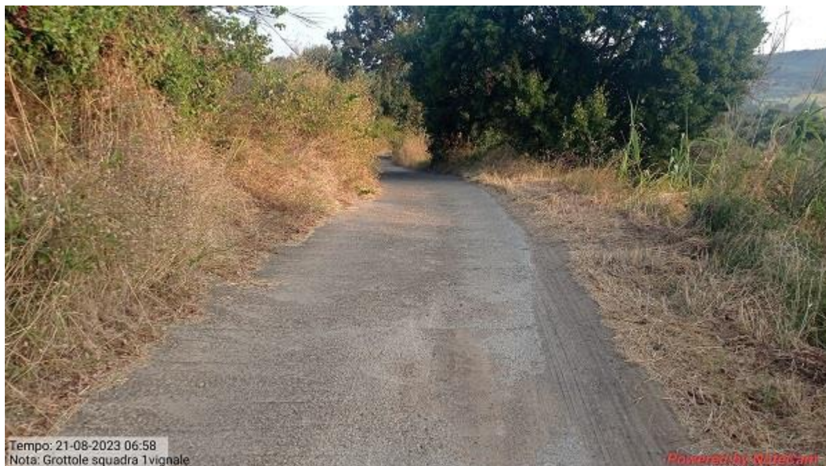
INTERVENTO 6.3.6.1 GROTTOLE STRADA COMUNALE VIGNALI FG 40
