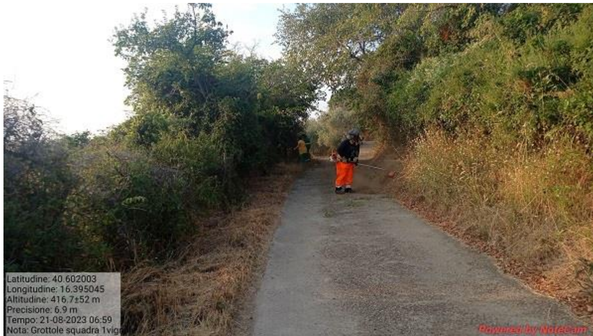
INTERVENTO 6.3.6.1 GROTTOLE STRADA COMUNALE VIGNALI FG 40
