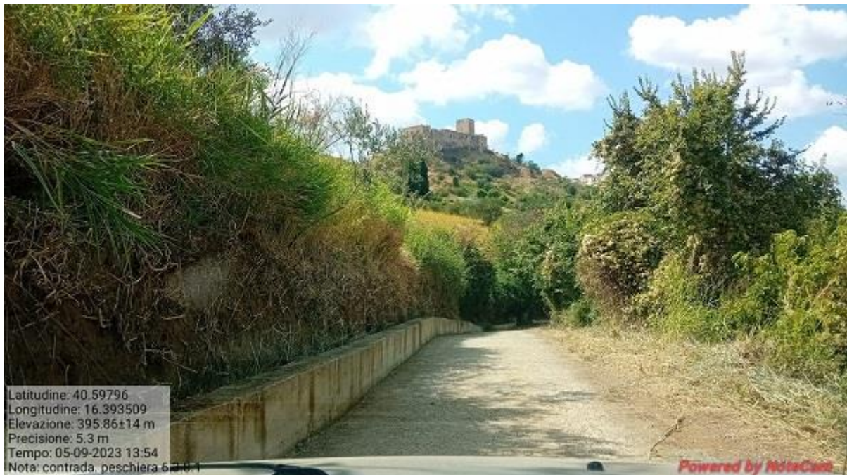
INTERVENTO 6.3.8.1 GROTTOLE STRADA COMUNALE PESCHIERA FG 50
