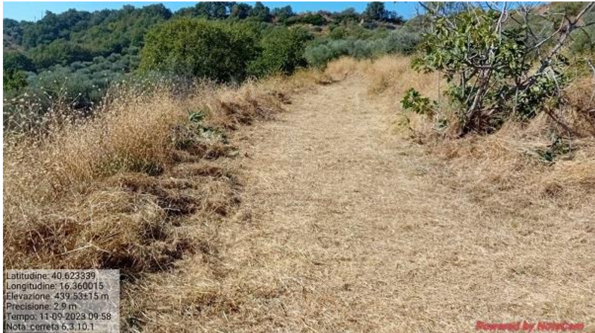
INTERVENTO 6.3.10.1 GROTTOLE STRADA COMUNALE CERRETA FG 20
