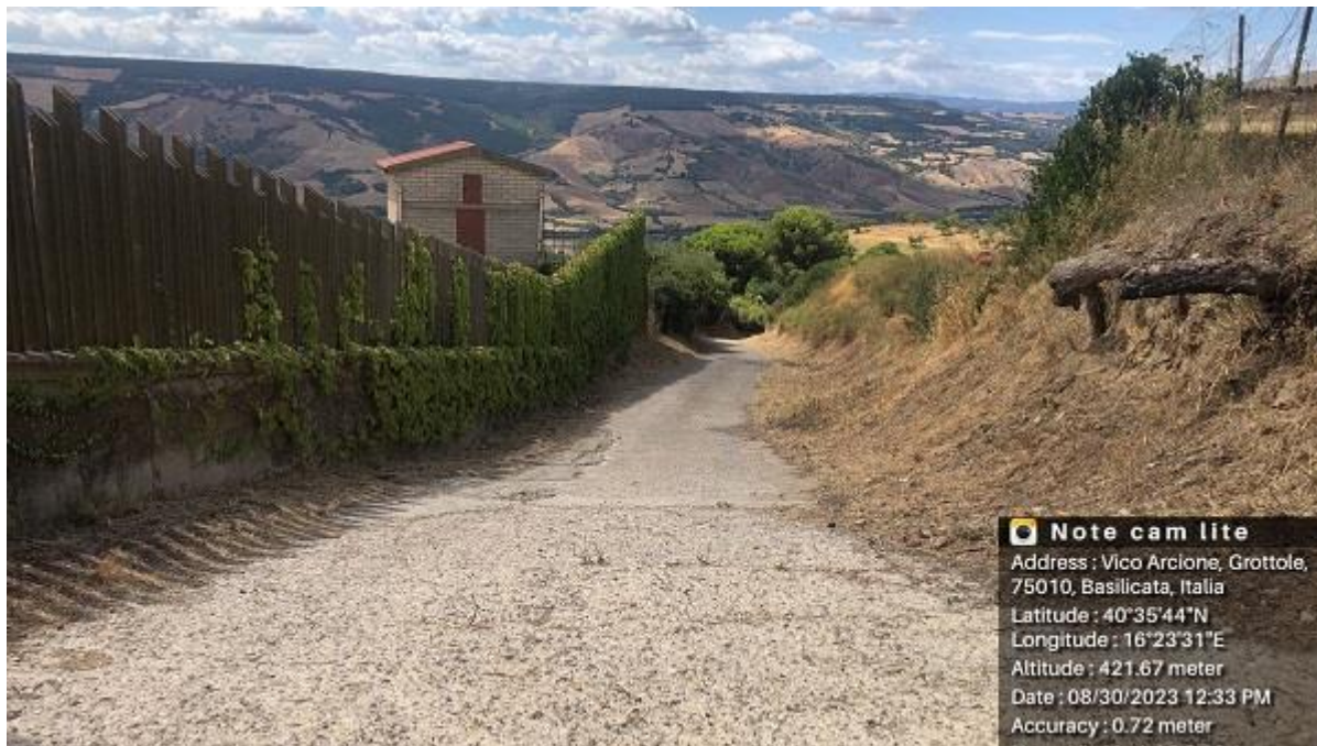
INTERVENTO GROTTOLE STRADA COMUNALE ARCIONE - VEDE PRIURBANO DOPO FOTO 27
