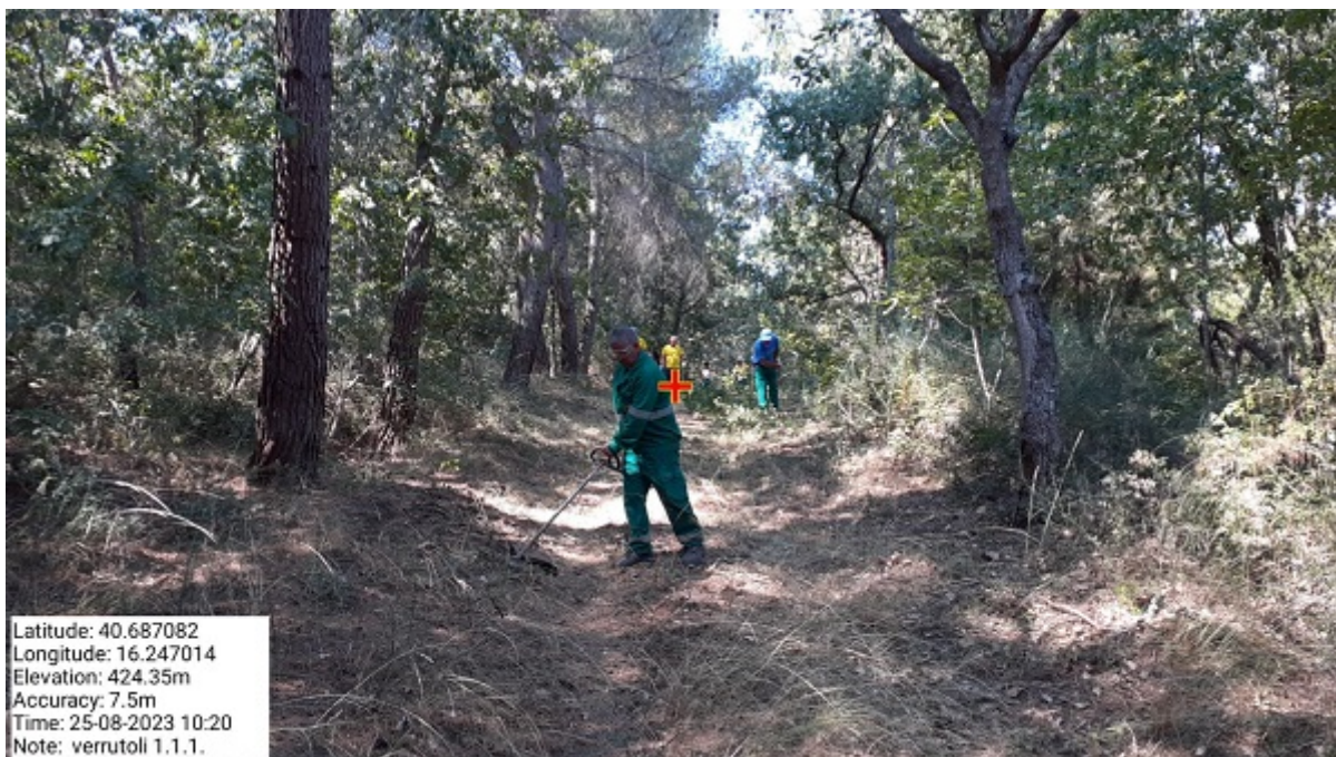
Int. 1.1.1 IRSINA Manutenzione di viale tagliafuoco attivo . Bosco di verrutoli DURANTE - Foto N°2
