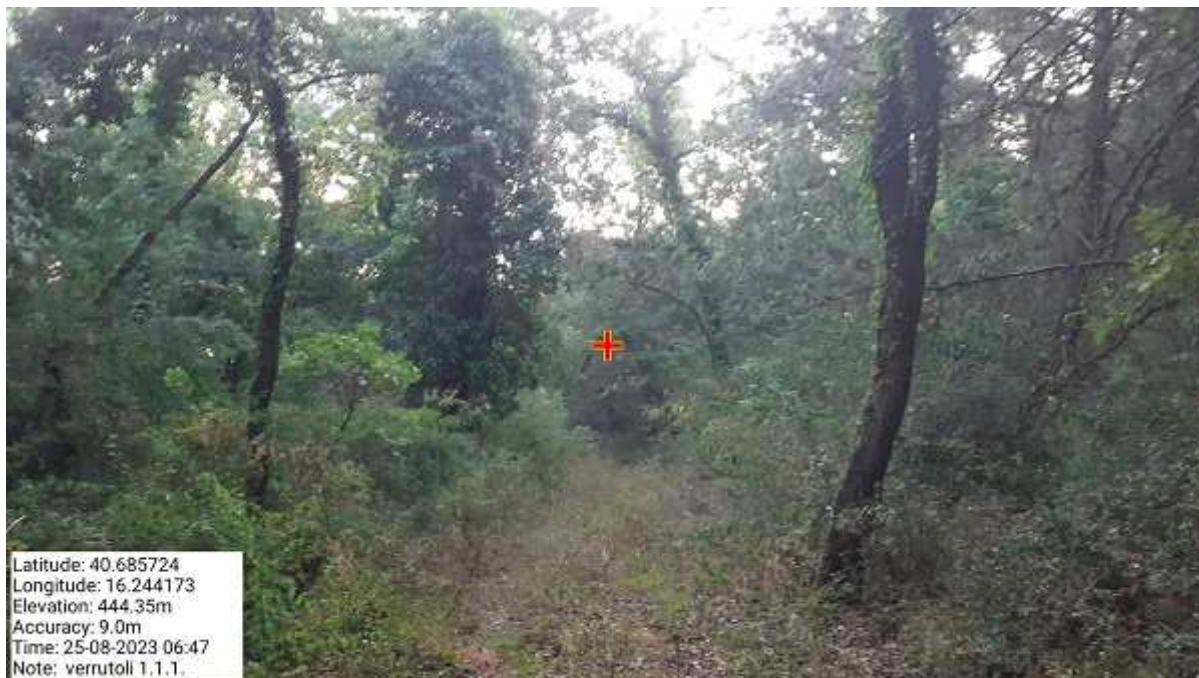
Int. 1.1.1 IRSINA Manutenzione di viale tagliafuoco attivo . Bosco di verrutoli PRIMA - Foto N°1
