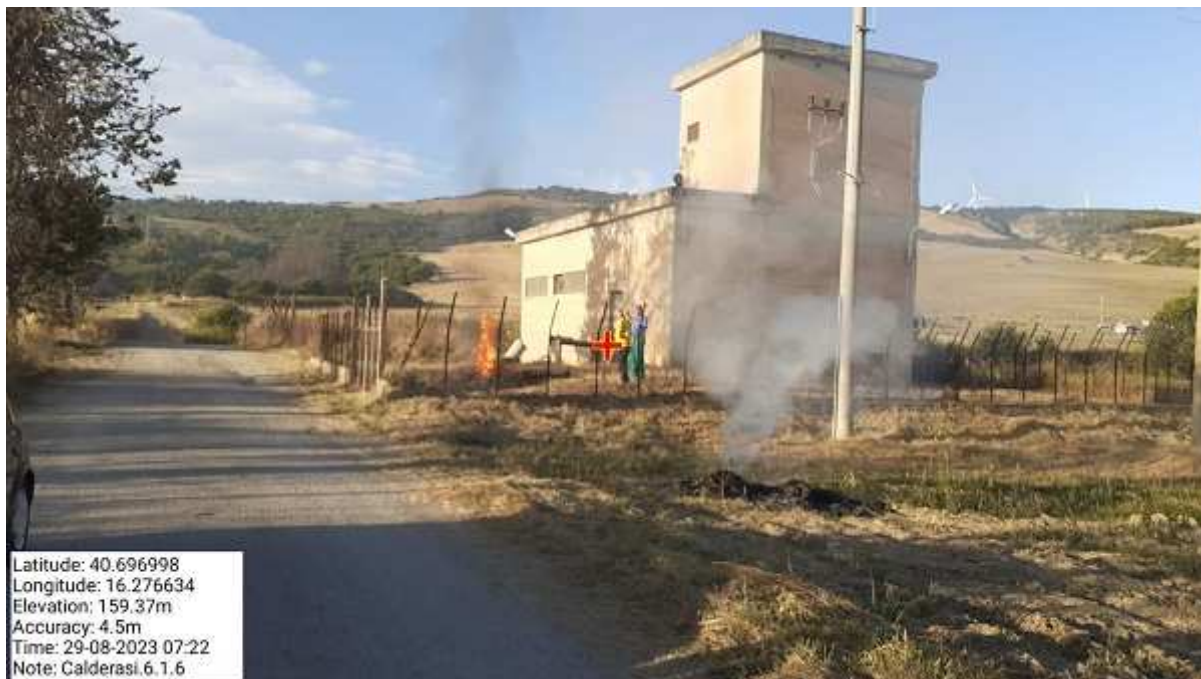
Int. 6.1.4 Irsina Fg.74 p.240 Impianto di sollevamento Distretto "S"
