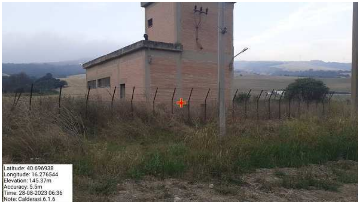
Int. 6.1.4 Irsina Fg.74 p.240 Impianto di sollevamento Distretto "S" PRIMA - Foto 16
