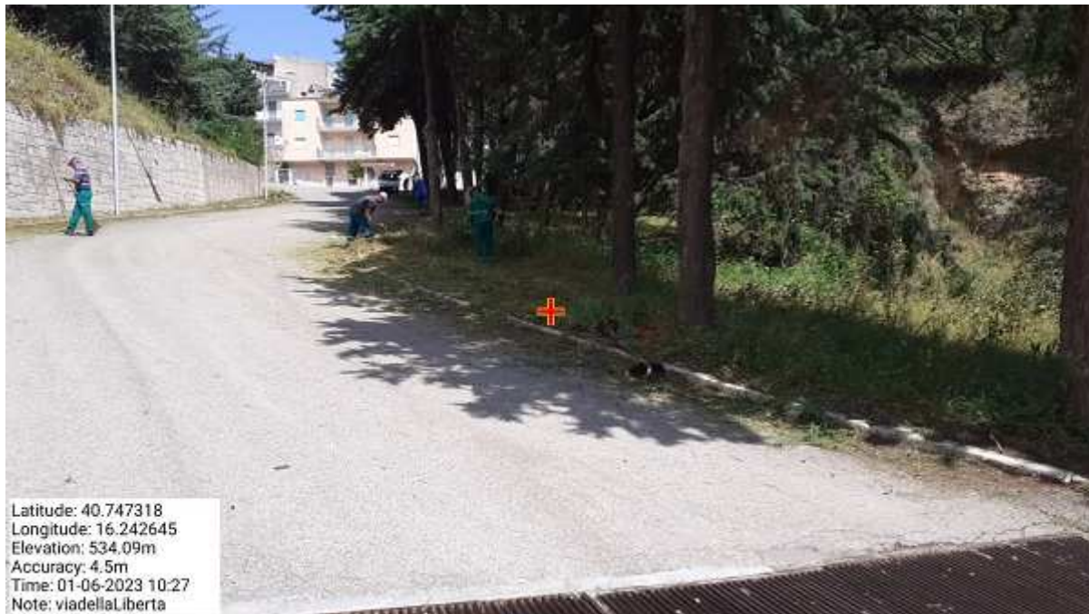
INTERVENT IRSINA INTERVENTO 2.1.1 IRSINA VERDE URBANO VIA DELLA LIBERTA DURANTE – FOTO 39
