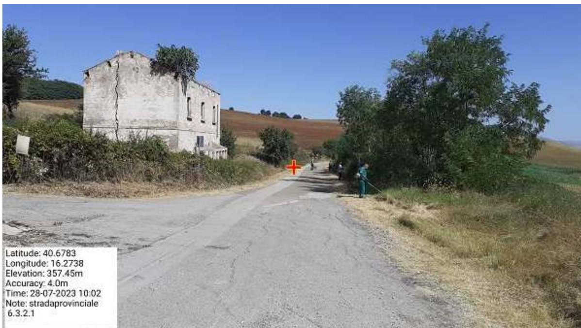
Int. 6.3.2.1 IRSINA strada provinciale per verrutoli fg 74
