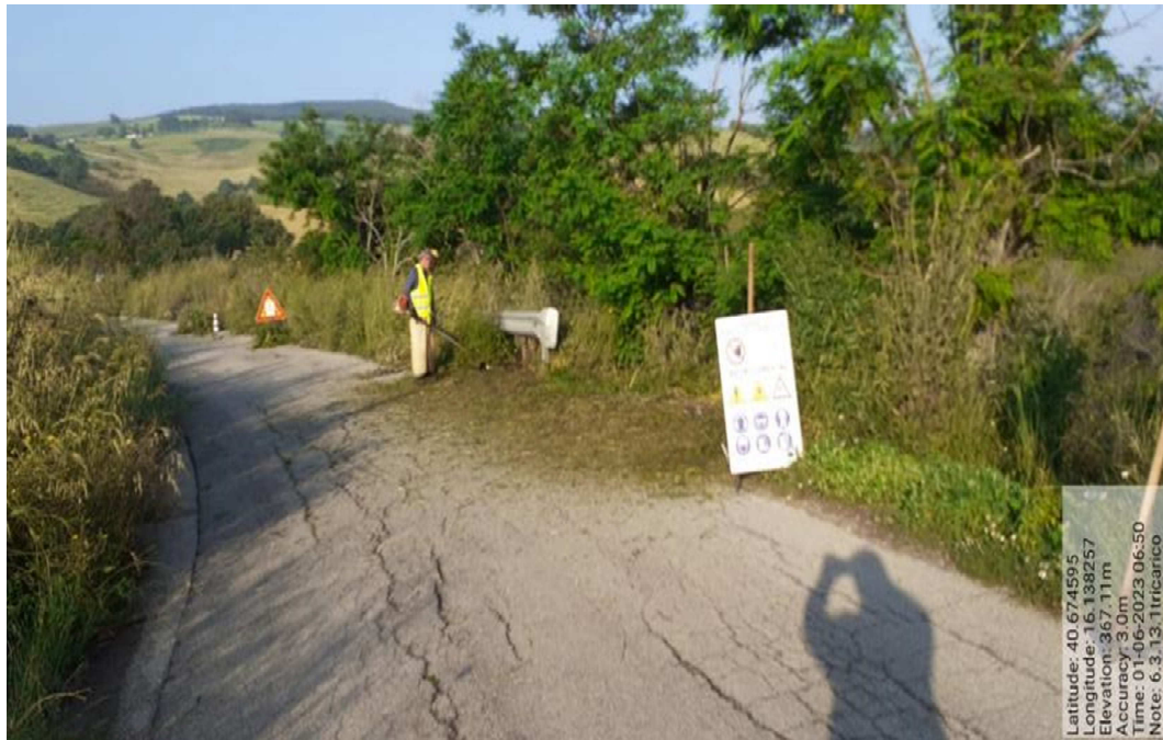
INTERVENTO 6.3.13 - TRICARICO Fg. 46-45-33-34-11-12-4 Strada Comunale Albanello-Cucno della Pic DURA
