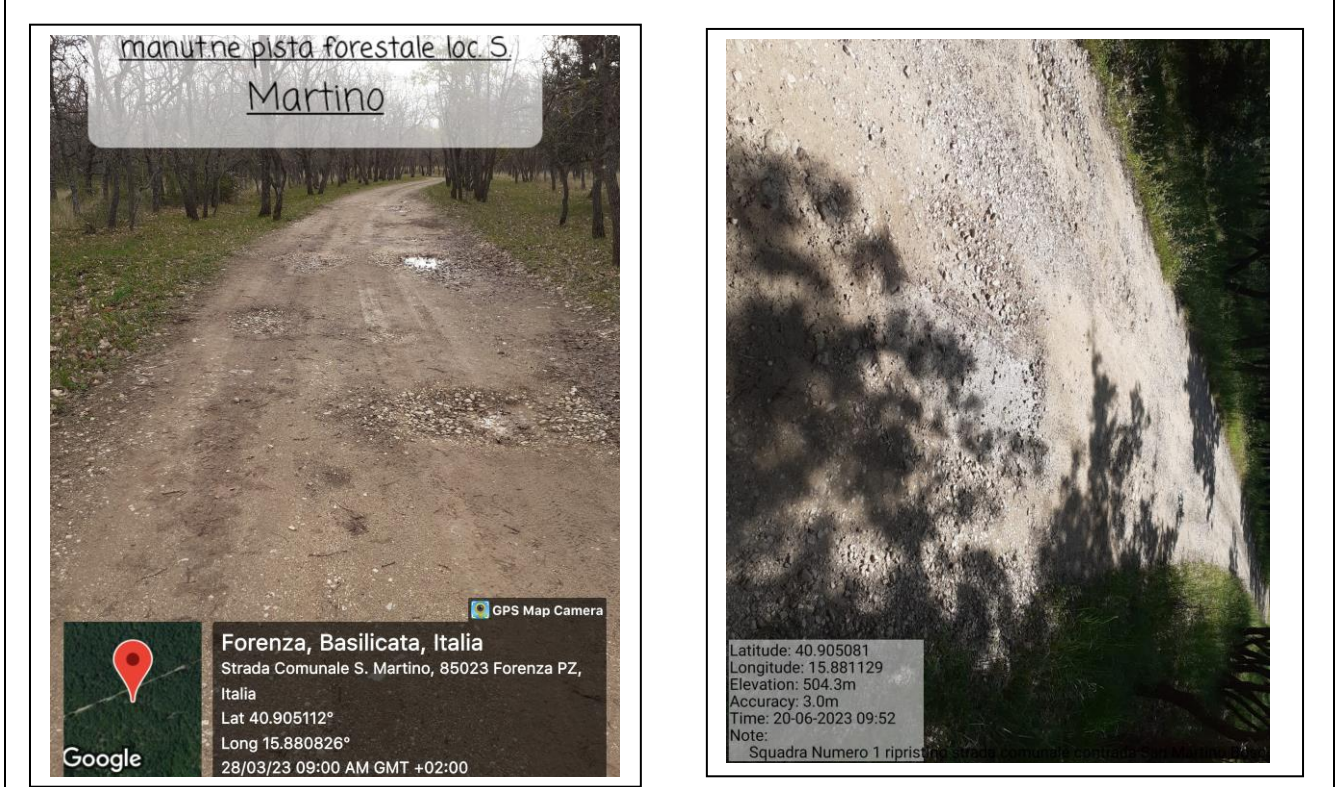
Foto prima Nome cantiere Foto dopo
