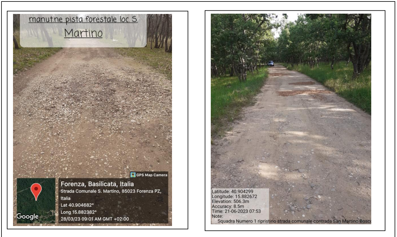
Foto prima Nome cantiere Foto dopo
