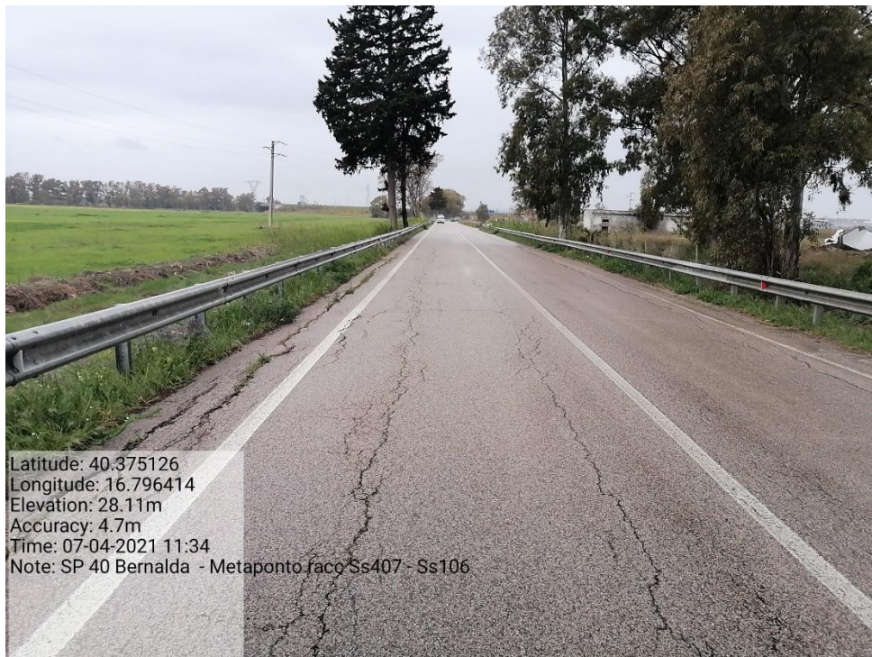
Intervento 5.1.3 Manutenzione Viabilità S.P 40 (Decespugliamento) SS 407-Metaponto L. — ANTE OPERAM
