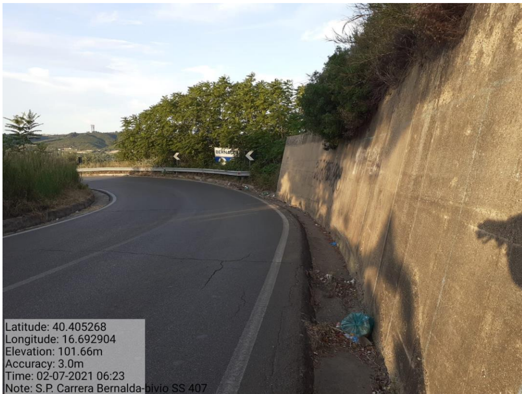
Intervento 5.2.1 Manutenzione Viabilità Provinciale (Pulizia Cunette) S.P Carrera — ANTE OPERAM
