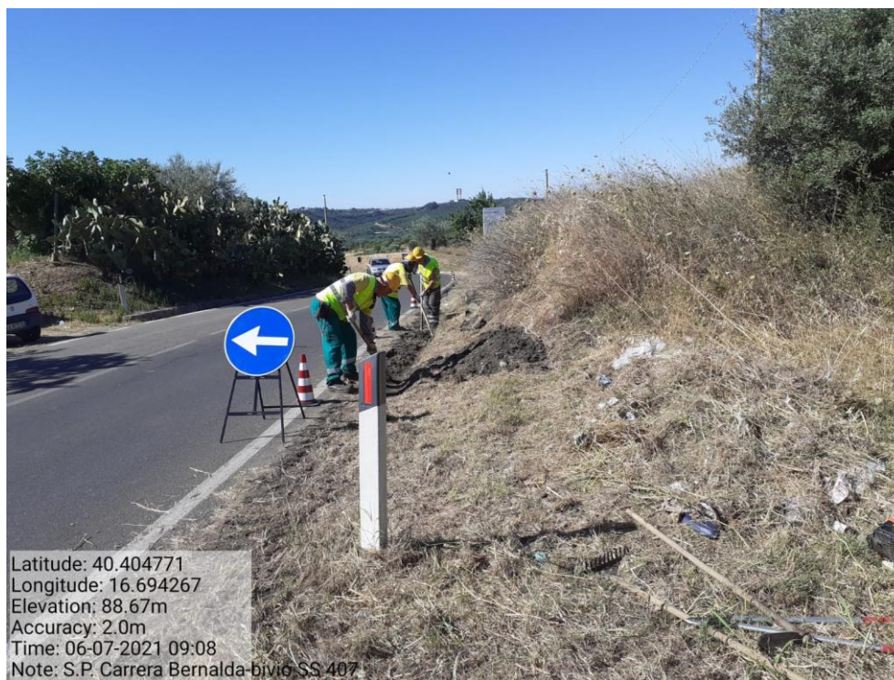
Intervento 5.2.1 Manutenzione Viabilità Provinciale (Pulizia Cunette) S.P Carrera — ANTE OPERAM
