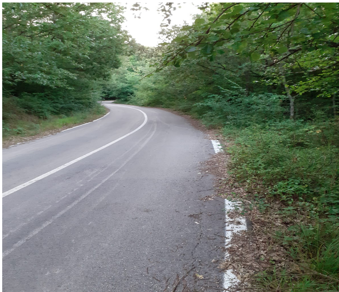
STRADA LOCALITA' CAPITUNNO - FILIANO – ANTE INTERVENTO
