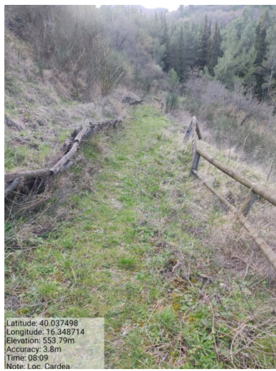
Foto 2 -AZIONE a) Int. n. 2. –Loc. Cardea -Stabilizzazione di pendio o scarpata.
