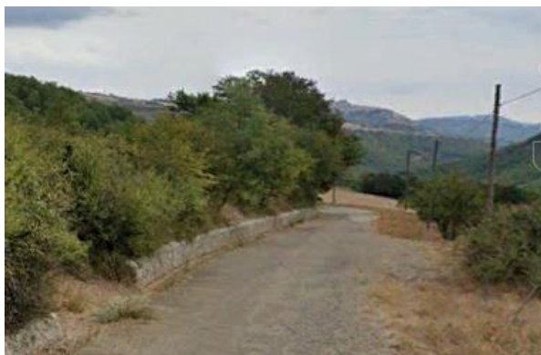
Int.6.3.6.1+6.3.6.2- Strada Casinale foto n°1
