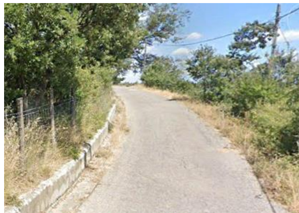
Int. 6.3.8.1+6.3.8.2 - Strada Valloni di sotto foto n°2
