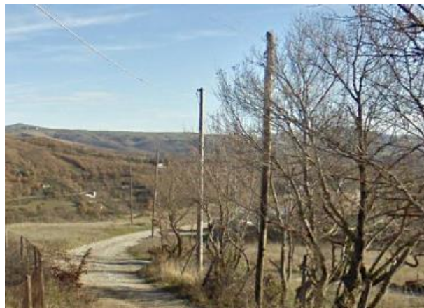
Int.6.3.9.1+6.3.9.2-Strada comunale Foresta foto n°1
