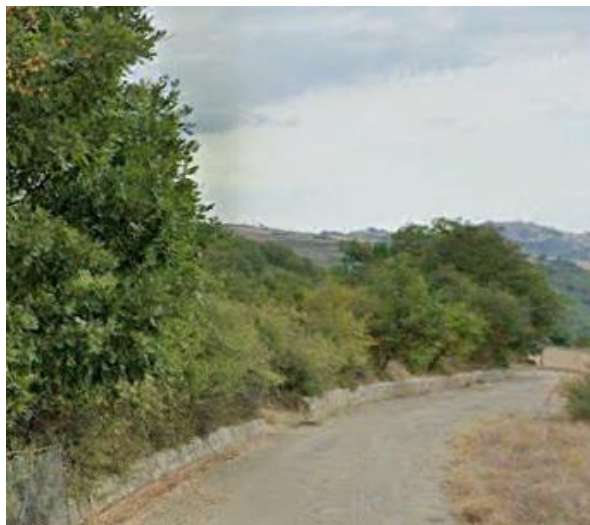
Int. 6.3.7.1+6.3.7.2 - Strada Cugni-Farneta foto n°2
