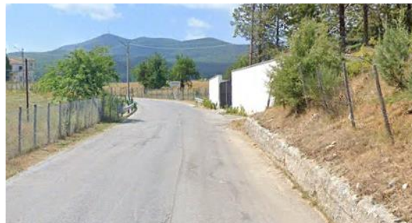
Int. 2.1.5- Area cimiteriale- fraz. Arioso Foto n°2
