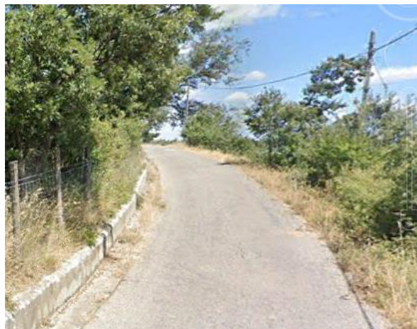
Int.6.3.3.1+6.3.3.2 -Strada Valloni di sopra-Santa Lucia foto n°1
