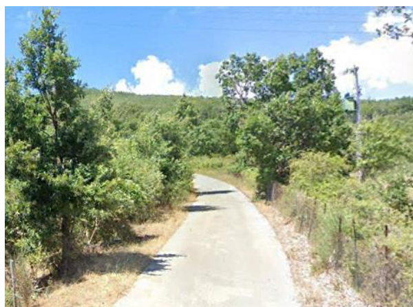
Int.6.3.10.1+6.3.10.2-Strada Cerrachiere foto n°1
