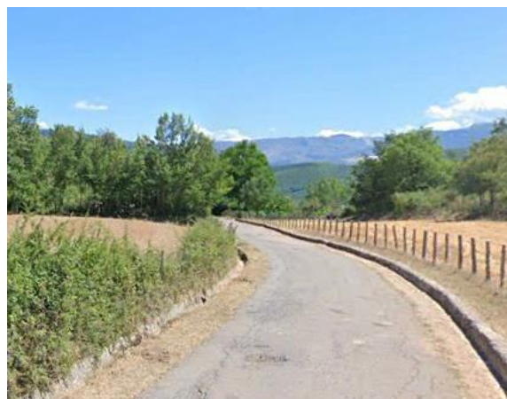
Int. 6.3.3.1+6.3.3.2-Strada Valloni di sopra-Santa Lucia foto n°2
