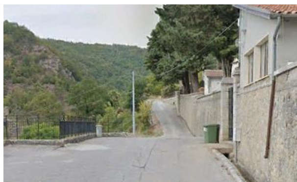
Int. 2.1.4- Area cimiteriale- Abriola Foto n°1
