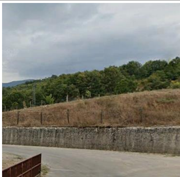
Int. 4.1.1- Strada forestale Discesa del Grillo – Pantanelle- Fiumicello foto n°1
