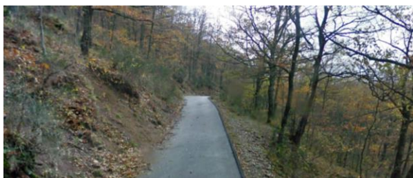
Int.6.3.13.1+6.3.13.2 - Strada Sellata - Monteforte
