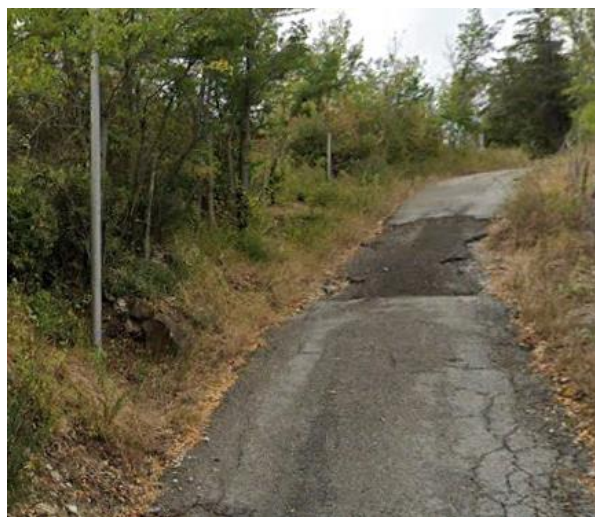
Int. 6.3.8.1 + 6.3.8.2- strada comunale Foresta- 1° tratto foto n°1
