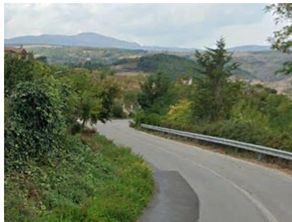
Int. 1.1.1. Fascia n°1 su S.P. 16 foto n°2
