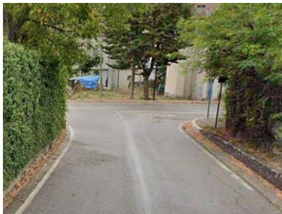
Int. 6.3.6.1+ 6.3.6.2 - strada comunale Fosso Santile foto n°1
