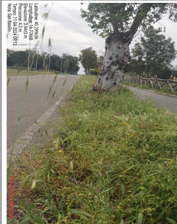
Int. 6.3.12 Strada loc. San Basilio Decesp. scarpate stradali
