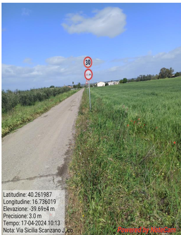
Int.6.3.16.1 Via Sicilia Decesp. scarpate stradali
