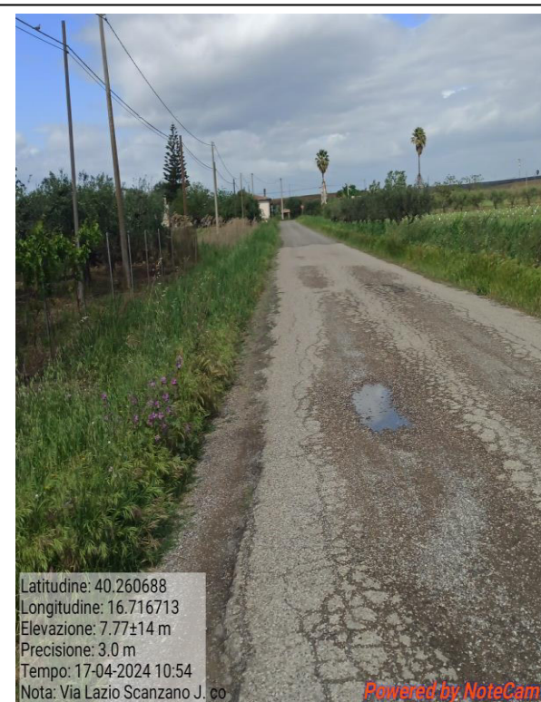
Int.6.3.18.1 Via Lazio Decesp. scarpate stradali
