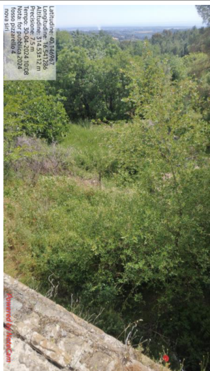
Int. 6.1.3 Canale Pizzarillo Nova Siri – Foto 3
