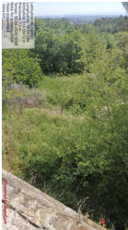
Int. 6.1.3 Canale Pizzarillo Nova Siri Foto 2
