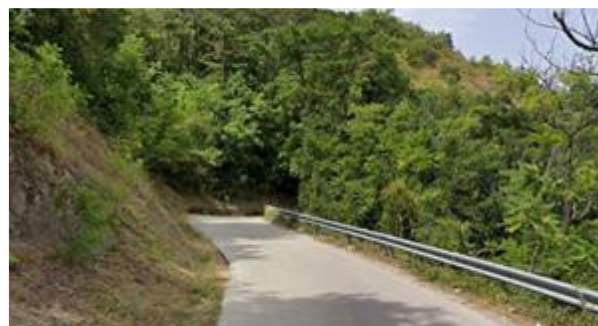
Int. 1.1.1 - 1° tratto fascia antincendio su SP Foto n° 2
