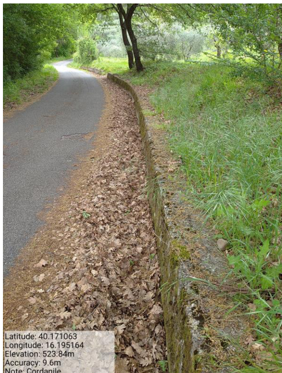
Int.6.3.5.1 – Cordanile – Foto 1
