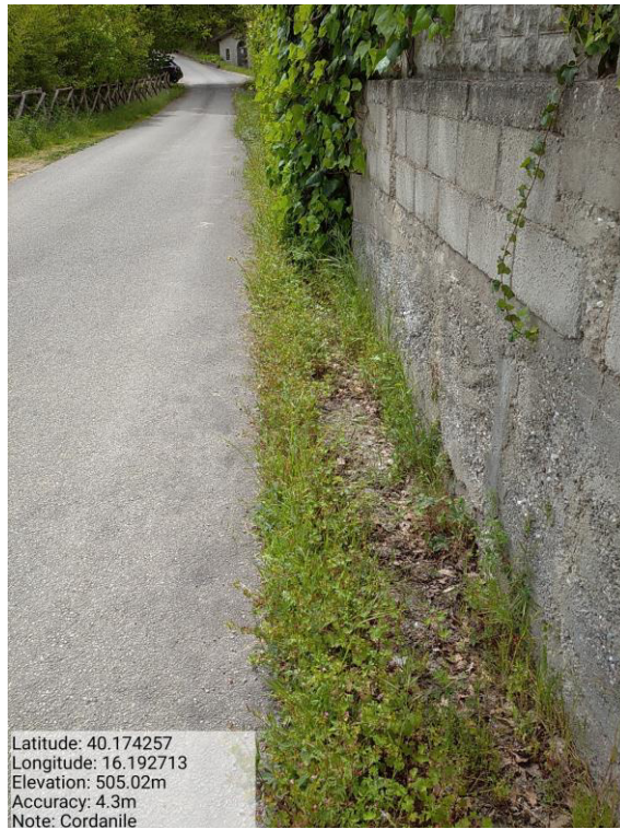
Int.6.3.5.1 – Cordanile – Foto 2
