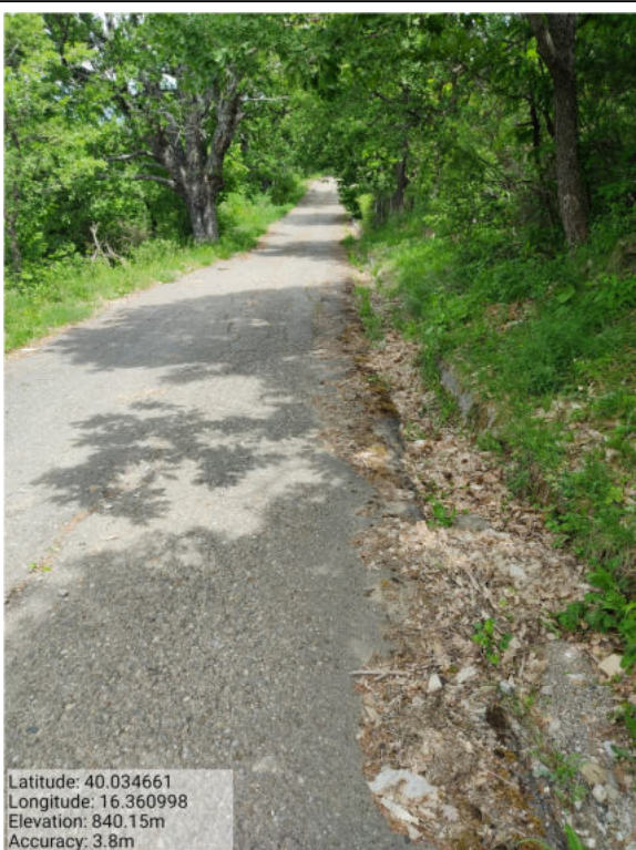
Int. _6.3_ Manutenzione Strade Loc. Monaca Foto 3
