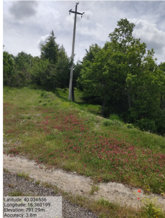
Int. _1.1.2_ Fascie Loc. Colonia - Foto 2
