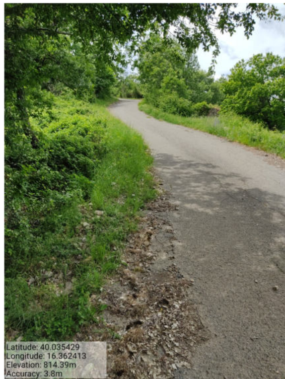
Int. _6.3_ Manutenzione Strade Loc. Monaca Foto 1
