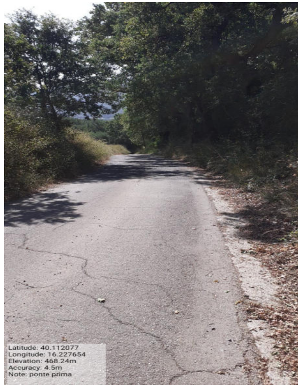
Int. 6.3.7 Loc. Ponte - Foto 1
