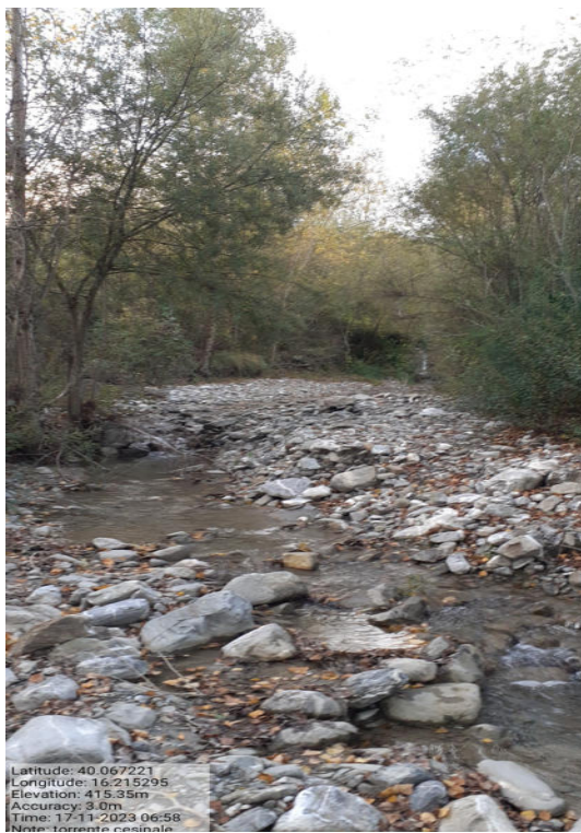
Int. 6.1.1 Ponte Cesinale - Foto 1
