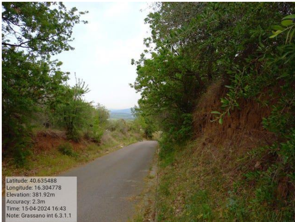
INTERVENTO 6.3.1.1 Grassano Fg.13-7-14 strada Comunale strettolone Foto n 5
