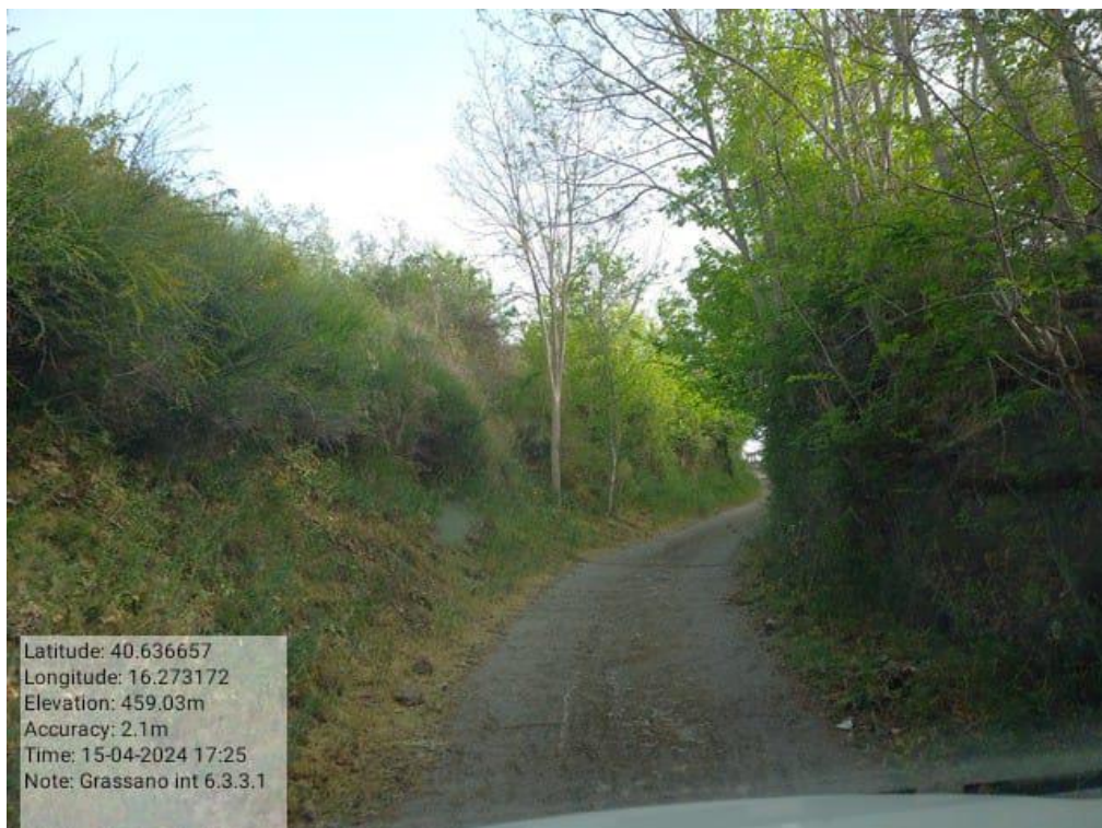
INTERVENTO 6.3.3.1 Grassano Fg.6 -3 Strada Comunale Manche 1
