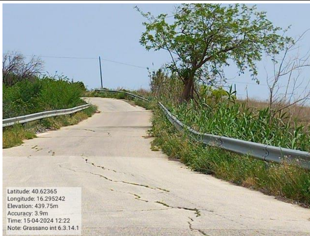
INTERVENTO 6.3.14.1 Grassano Fg.31-27-23-16-17 Strada Comunale Petrullo
