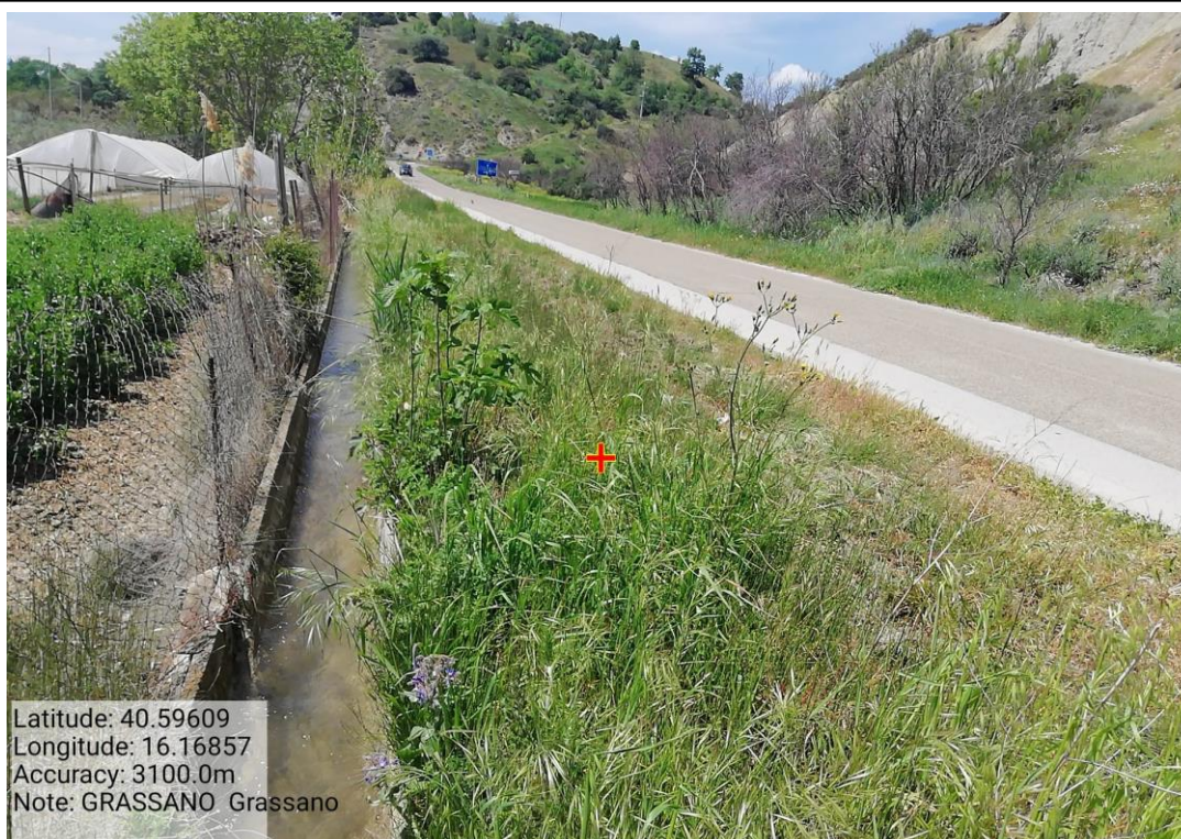
INTERVENTO 6.1.6.2 Grassano Fg.28-29-26-30-31 Canaletta Irrigazione - Distribuzione Principale Distretto 3 (tratto A) Foto n. 40
