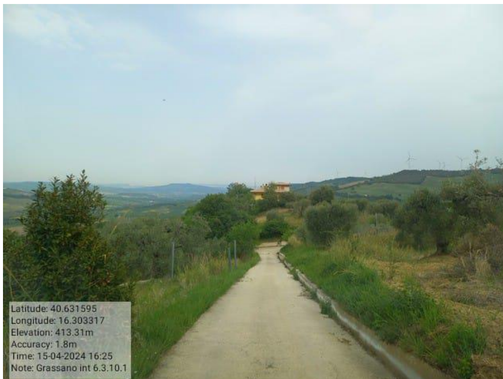
INTERVENTO Intervento 6.3.10.1 Grassano Fg.13 Strada Comunale Serra Martello
