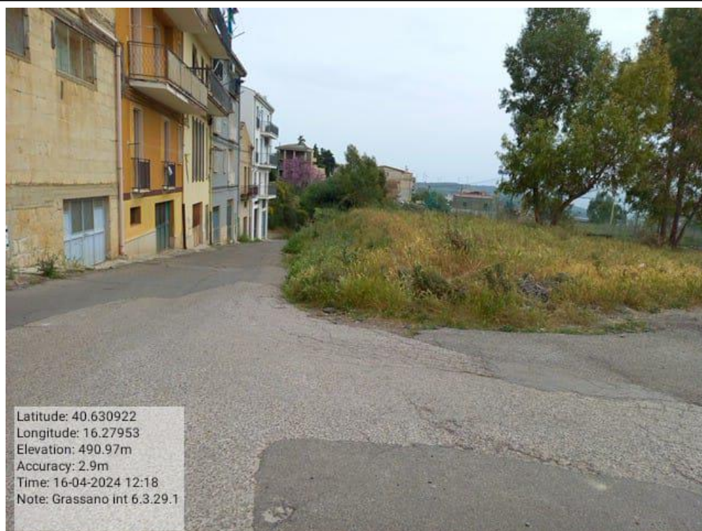
INTERVENTO 6.3.29.1 Grassano Fg.15 Via Cimitero Foto n. 24
