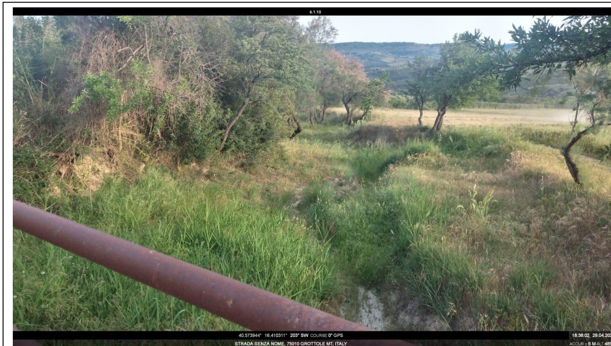
Int. 6.1.9 Grottole Fg.60 Canale 9 Ischia Basento - Foto 23 Lon.40.574524 Lat.16.408381
