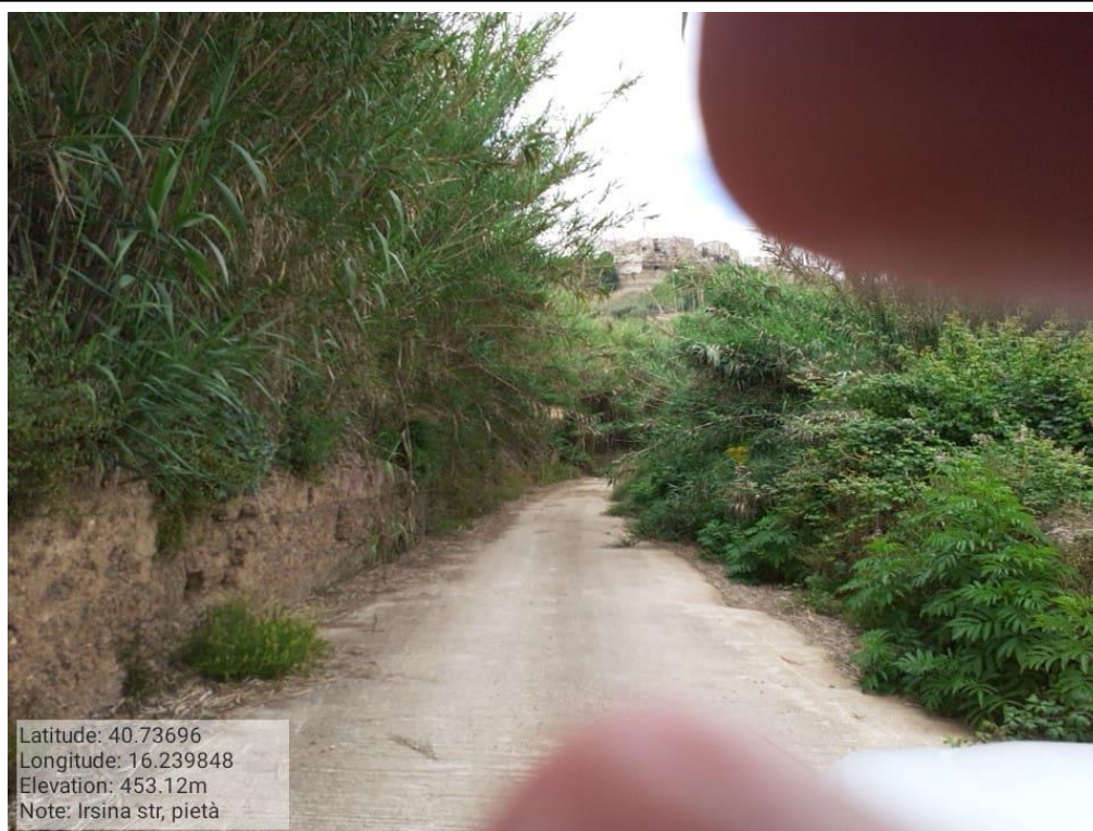
Int. 6.3.4.1 Irsina Fg.44 Strada comunale la Pietà
