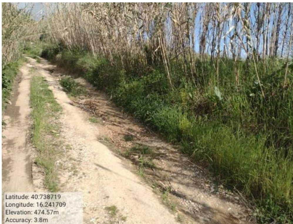
Int. – 6.3.6.2 Irsina F.44 Strada Comunale Cotrada dei Greci Foto N.48
