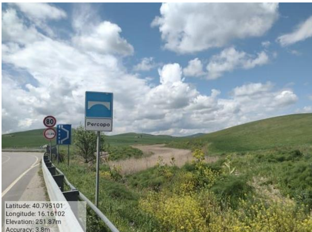
Int. 6.1.7 Irsina Fg.39 part. AcqueTORRENTE PERCOPO
