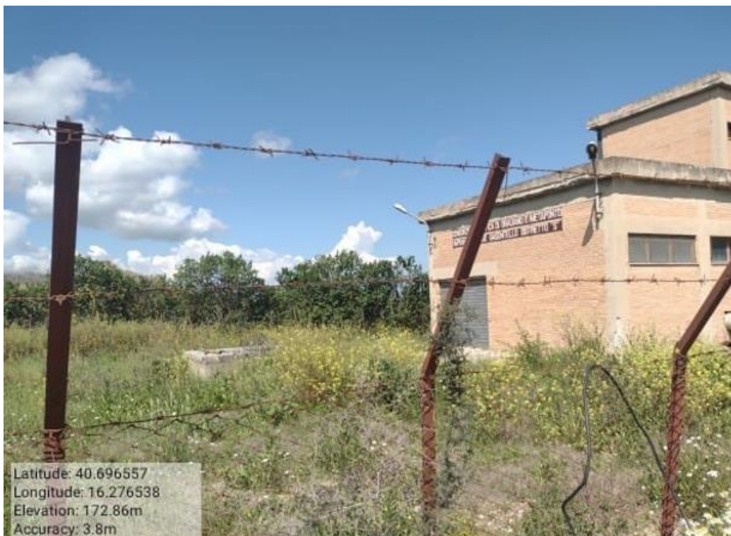
Int. 6.1.4 Irsina Fg.74 p.240 Impianto di sollevamento Distretto "S"
