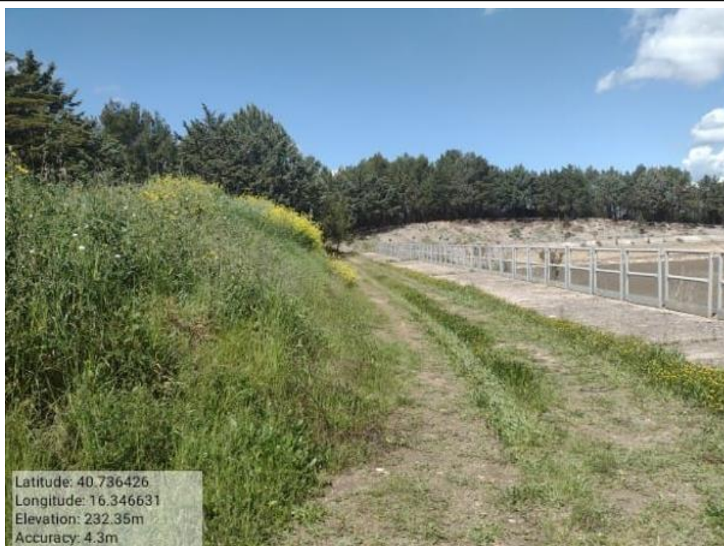
Int. 6.1.3 Irsina Fg.49 Part.45-84-83 Vasca di accumulo "Vasca B" S. Maria d'Irsi
