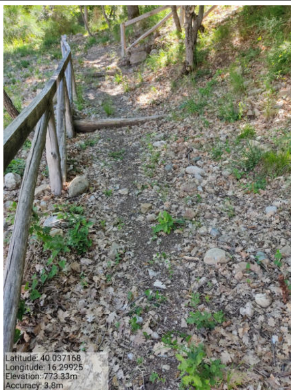
Int. _6.4._ Manutenzione Staccionate Foto 2
