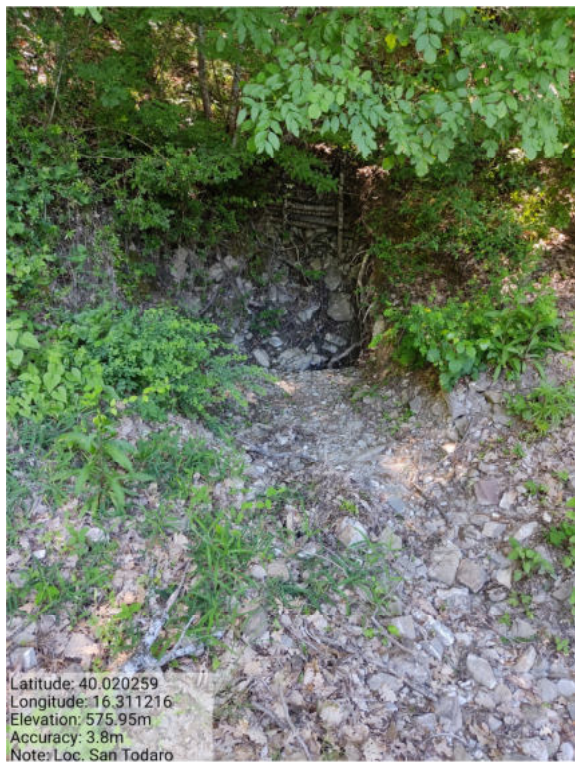
Int. _6.2._ Manutenzione Canalette Foto 1
