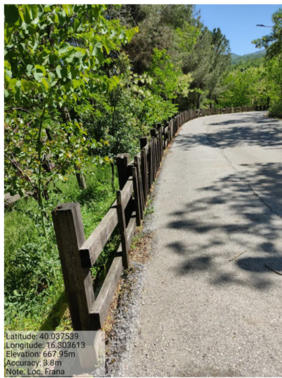
Int. _6.4._ Manutenzione Staccionate Foto 1
