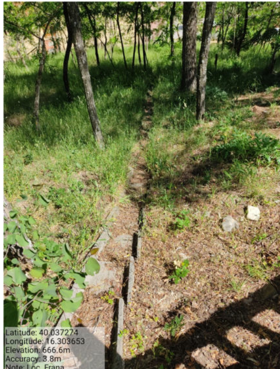
Int. _6.2._ Manutenzione Canalette Foto 2
