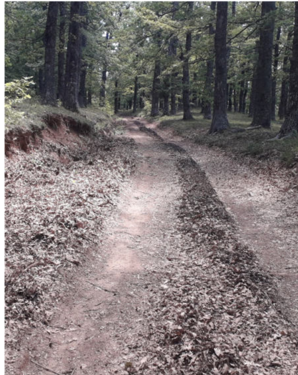
Int. _1.2_ Manutenzione Piste Foto 2
