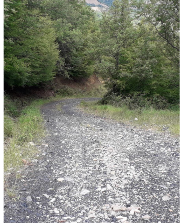
Int. _4.1.1_ Manutenzione Piste Foto 4
