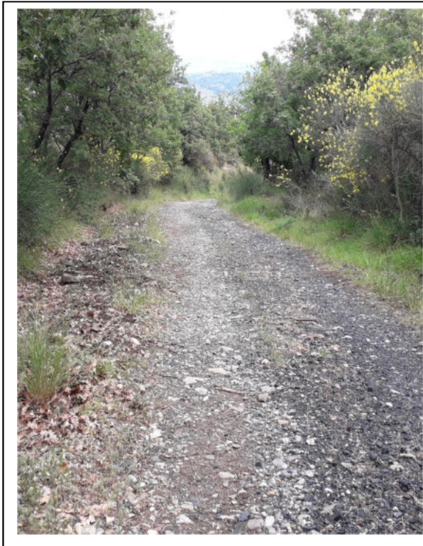
Int. _4.1.1_ Manutenzione Piste Foto 2
