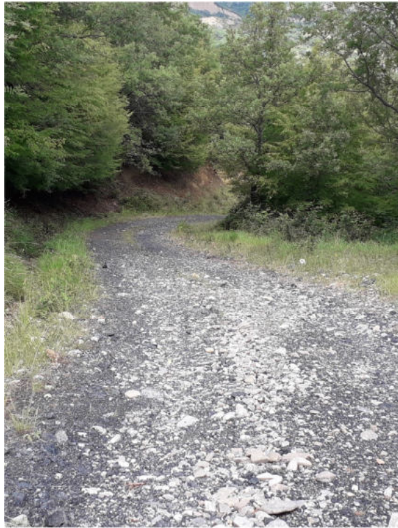
Int. _4.1.1_ Manutenzione Piste Foto 3
