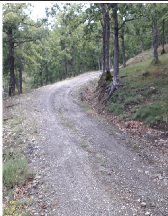
Int. _1.2.1_ Manutenzione Piste Foto 2
