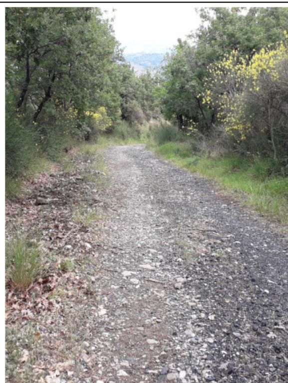
Int. _4.1.1_ Manutenzione Piste Foto 3
