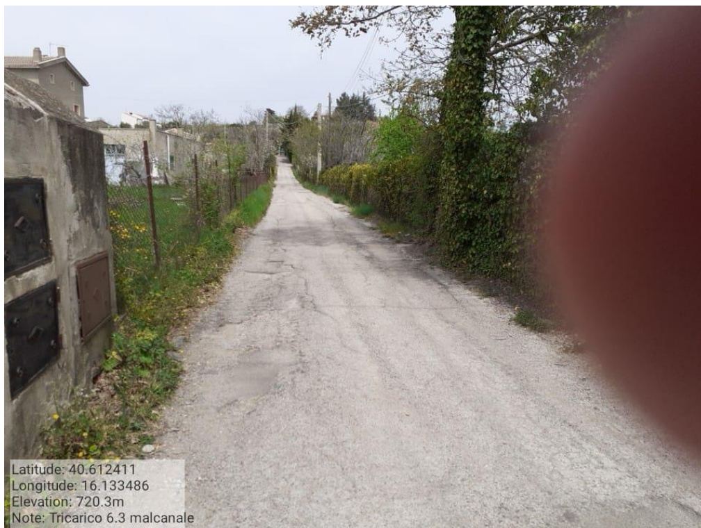
INTERVENTO 6.3.6.1- TRICARICO STRADA COMUNALE MALCANALE 2 FG. 64
