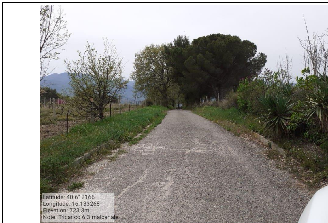
INTERVENTO 6.3.4.1 - TRICARICO STRADA COMUNALE MALCANALE FG. 64
