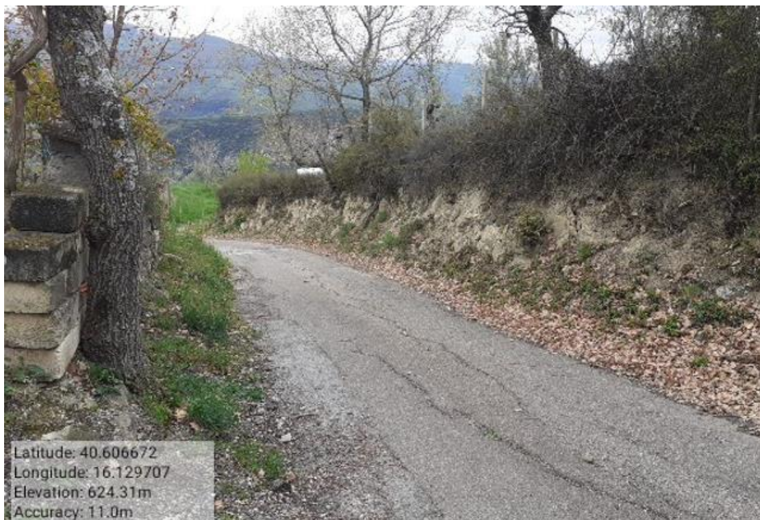
INTERVENTO 6.3.10.1- TRICARICO STRADA COMUNALE MALCANALE 7 FG. 64
