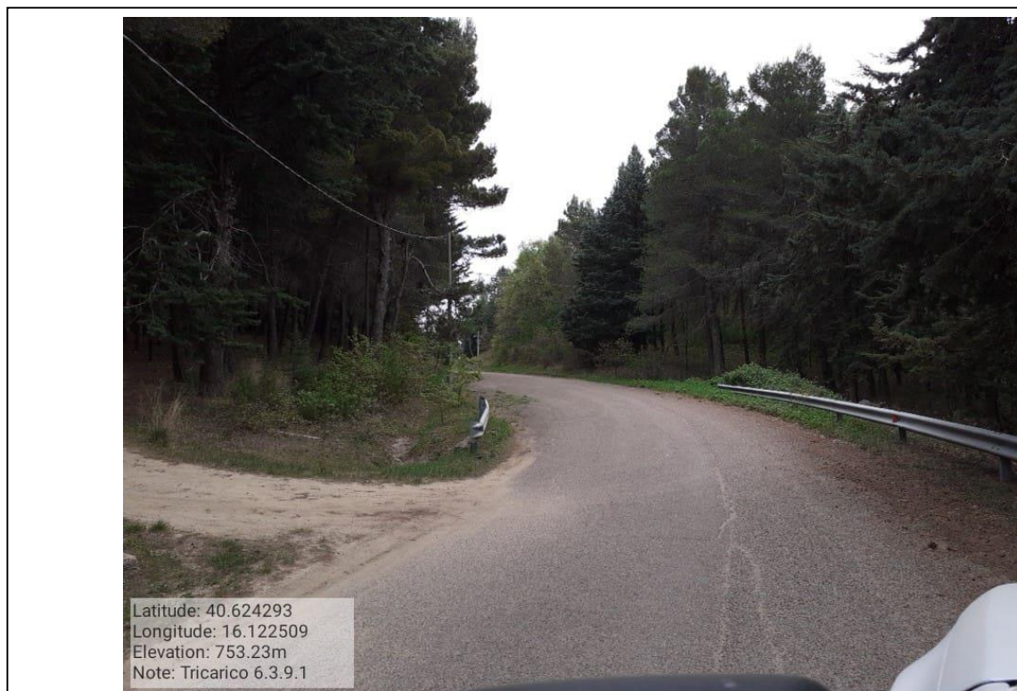
INTERVENTO 6.3.9.1 - TRICARICO STRADA COMUNALE SALUMICIFIO FG 59
