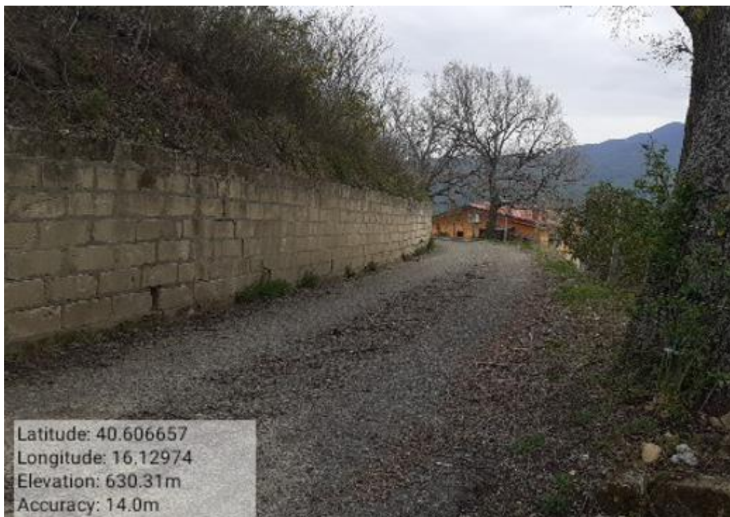
INTERVENTO 6.3.8.1.- TRICARICO STRADA COMUNALE MALCANALE 6 FG. 64
