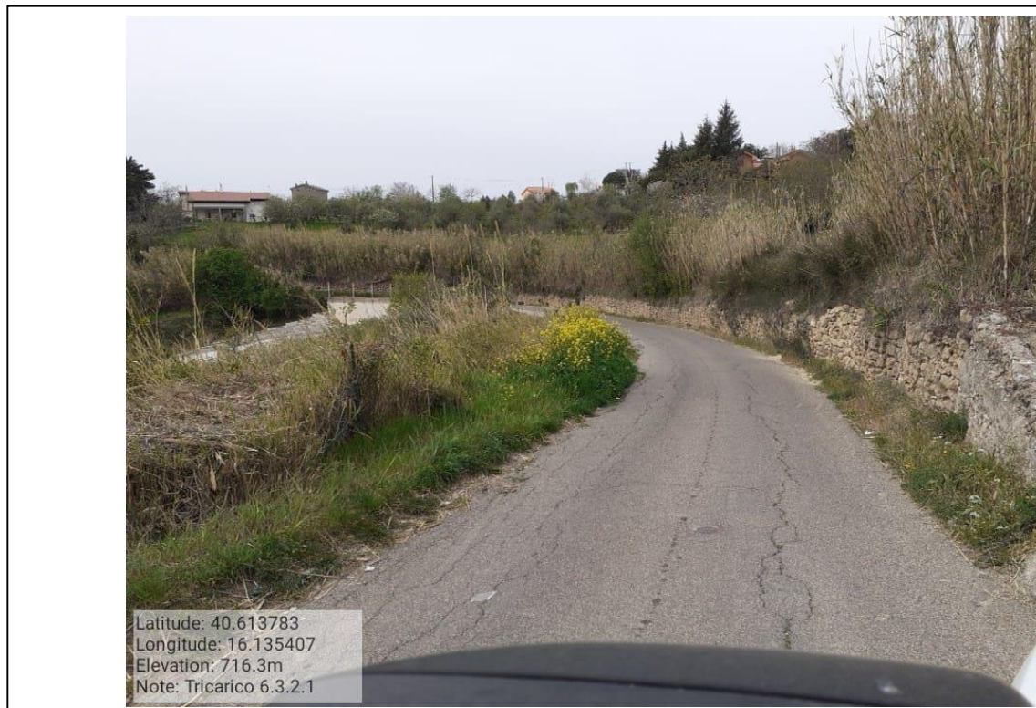
INTERVENTO 6.3.2.1 - TRICARICO STRADA COMUNALE MALCANALE 3 FG. 64
