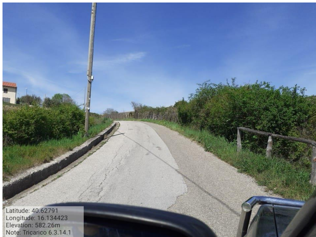
INTERVENTO 6.3.14.- TRICARICO STRADA COMUNALE SANT ANDREA 1 FG. 54/60 Foto n. 53
