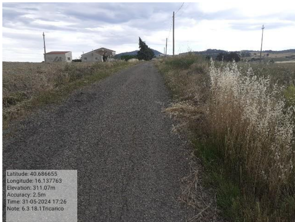
INTERVENTO 6.3.18.- TRICARICO STRADA COMUNALE FORTE ORLANDO FG.4
