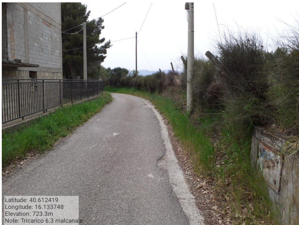
INTERVENTO 6.3.3.1.- TRICARICO STRADA COMUNALE MALCANALE 1 FG. 64
