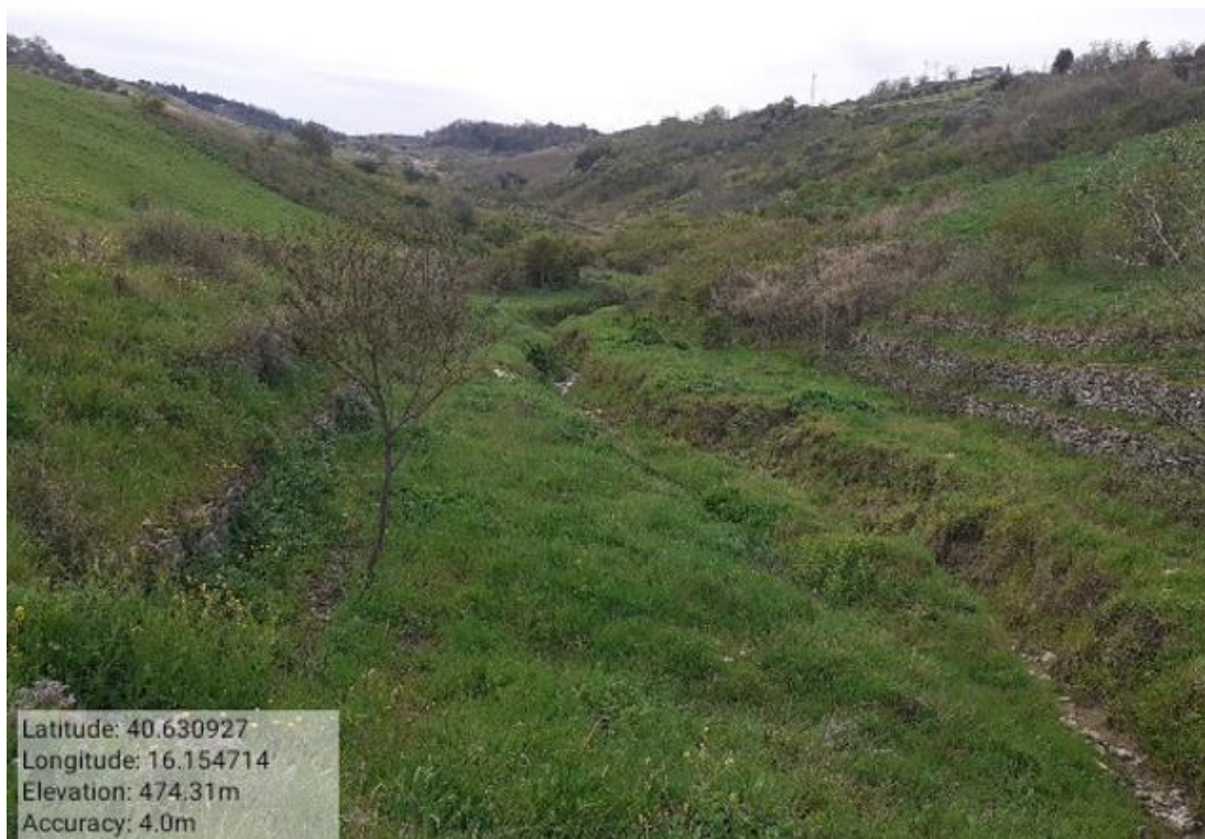
INTERVENTO 6.1.7 - TRICARICO Fg. 61 PARTE ACQUA VALLONE CASTAGNONE Foto n. 36
