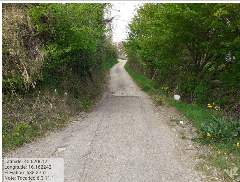
INT 6.3.11 - TRICARICO TRATTURO TRICARICO GRASSANO 1° TRATTO BIVIO TRICARICO CALLE FG.57 Foto n. 50
