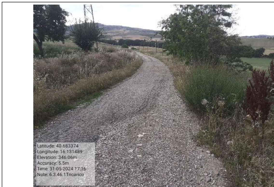
INTERVENTO 6.3.46.1 Tricarico Strada per il Casone 82
