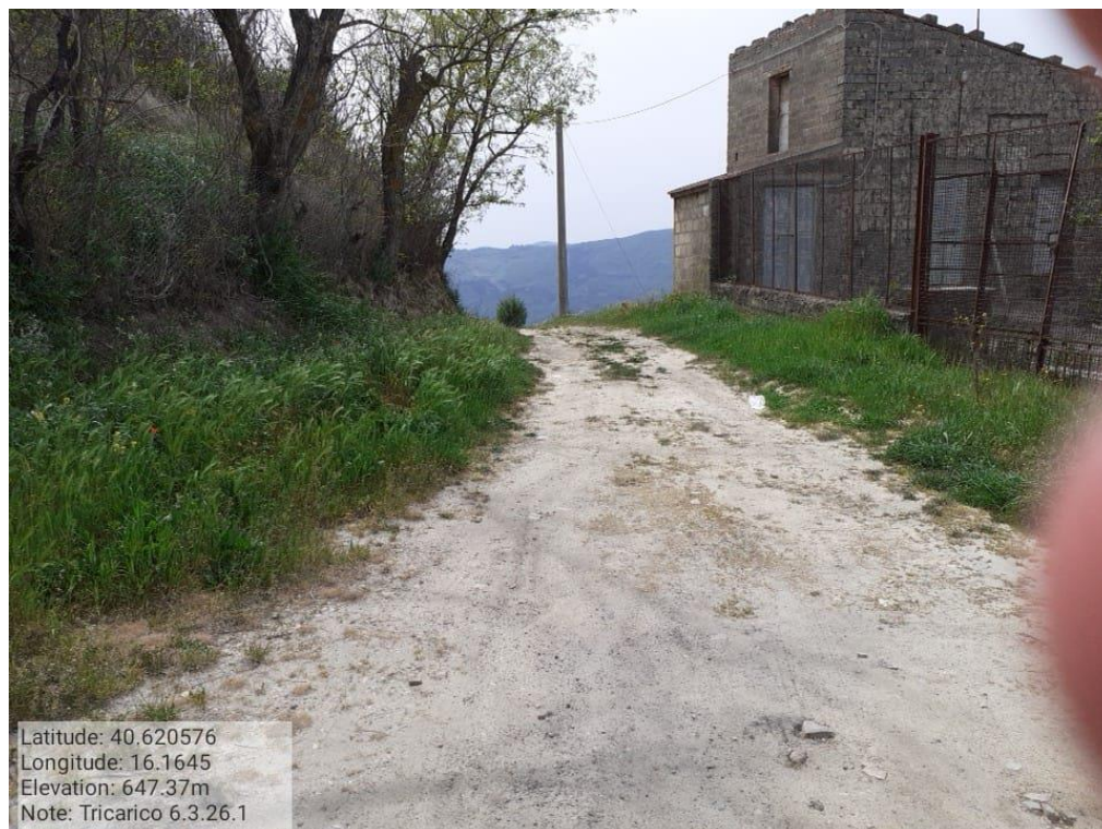
INTERVENTO 6.3.26.- TRICARICO EX COLLEGAMENTO BASENTANA FG.66-67
