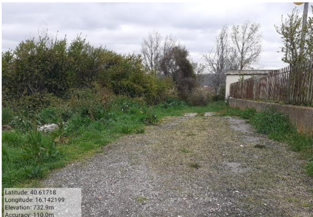
INTERVENTO 6.1.5 Tricarico Fg.65 Pretura - Fontana Vecchia
