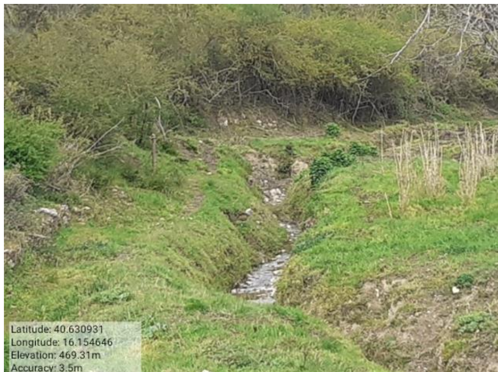
INTERVENTO 6.1.8- TRICARICO Fg. 61 PARTE ACQUA VALLONE CASTAGNONE (AFFLUENTE) Foto n. 37
