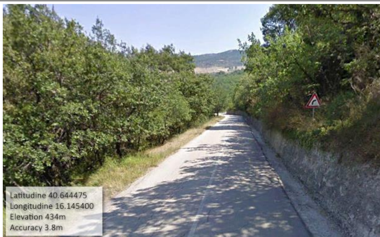
INTERVENTO 6.3.23 - TRICARICO STRADA PROVINCIALE BOCCANERA FG.46-47-35-36-21 1° TRATTO Foto n.63
