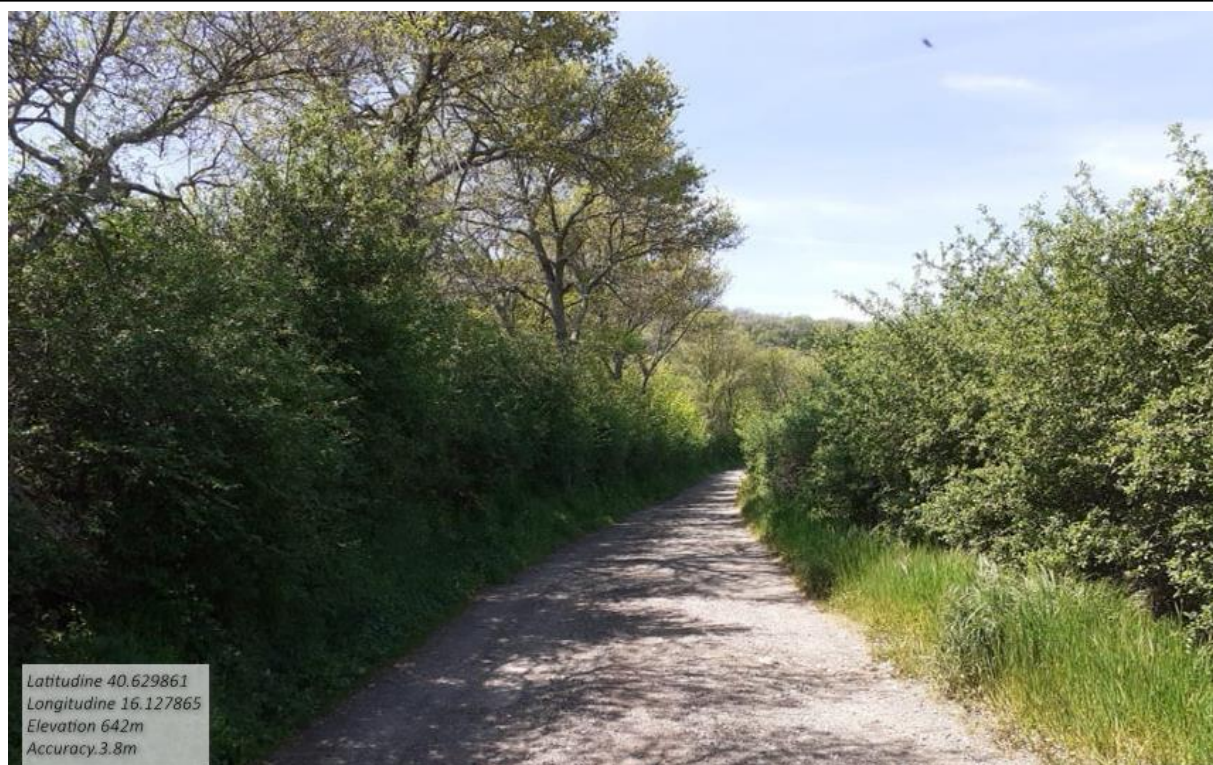
INTERVENTO 6.3.15 - TRICARICO STRADA COMUNALE SANT ANDREA 2 FG. 53/54 Foto n. 54
