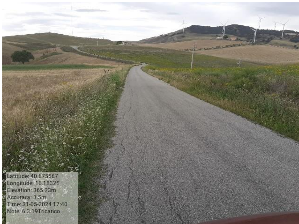
INTERVENTO 6.3.19.- TRICARICO T Fg 15-14-6-10 Strada Comunale Serramendola Bassa Foto n. 60
