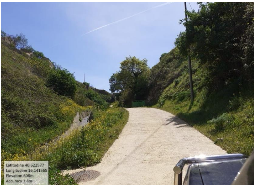
INTERVENTO 6.1.1- TRICARICO Fglia 65 part. Acque TORRENTE CACARONE TRATTO 2° Foto n. 30
