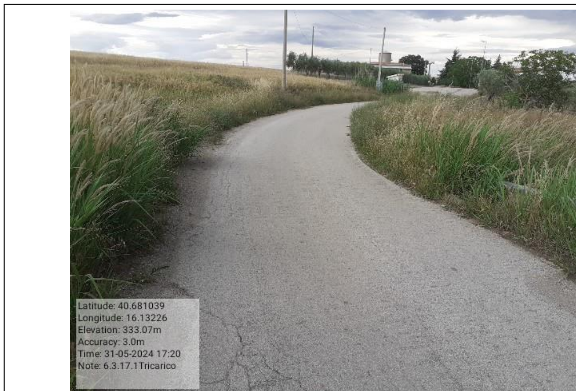
INTERVENTO 6.3.17 - TRICARICO STRADA COMUNALE SAN MARCO 2 FG.12 Foto n. 57
