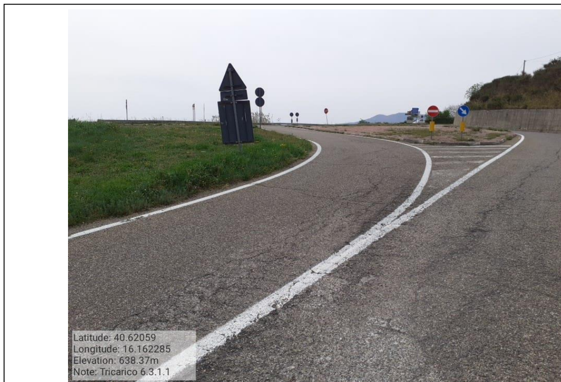
INTER 6.3.1 - TRICARICO COLLEGAMENTO BASENTANA IANO DELLE GINESTRE FG. 70/68/66/65 Foto n.40
