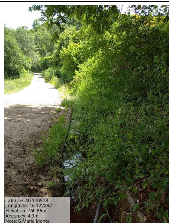
Int.6.3.6.1 – Strada S. Maria Monte - Foto 1
