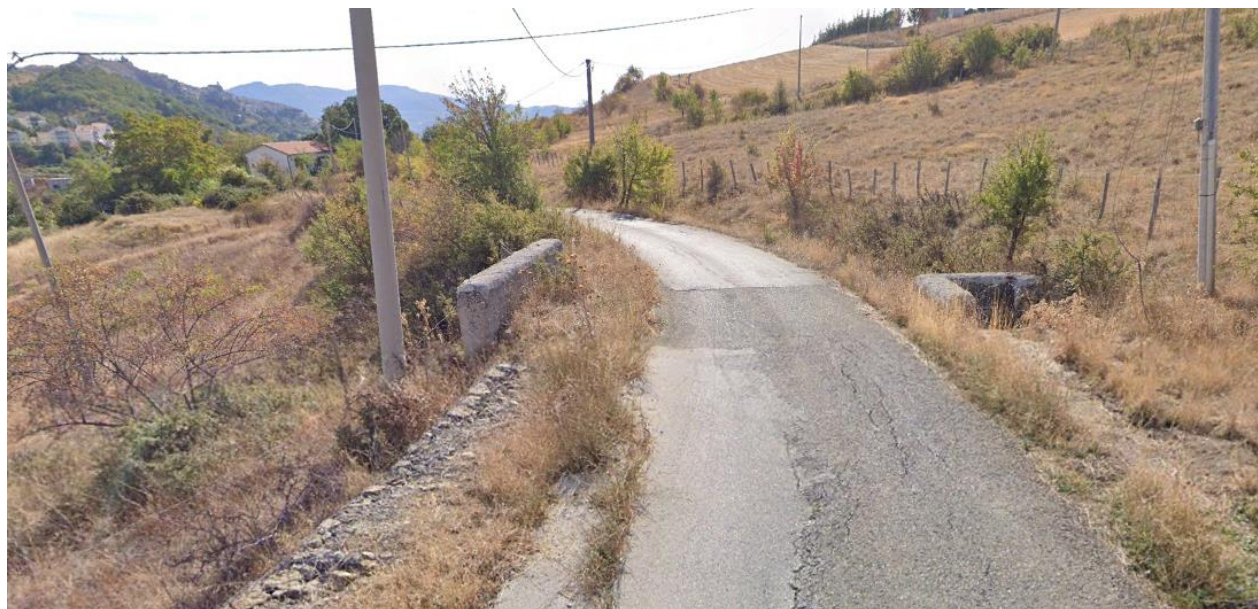
Azione a)4 - Int. 2 - Strada Santa Pote - Convogliamento acque
