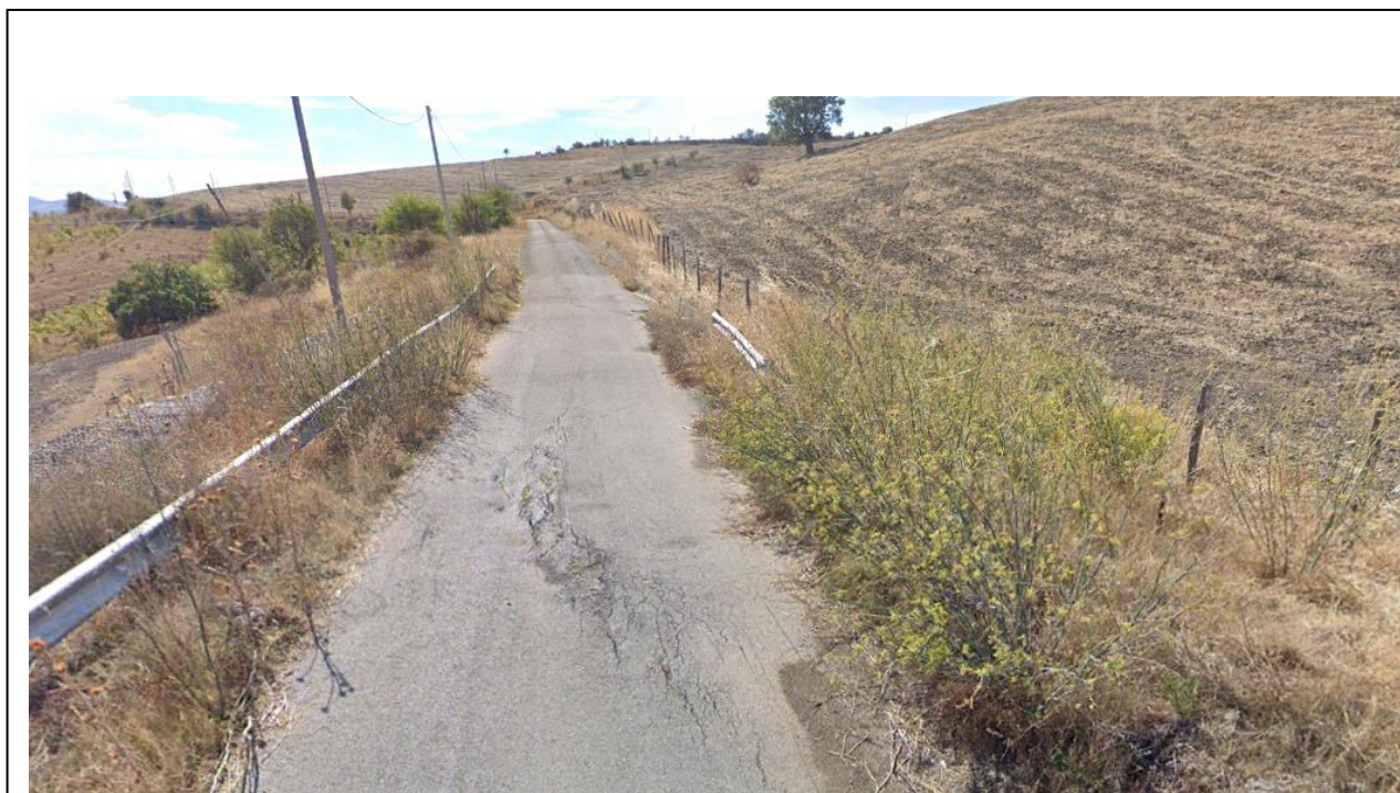
Azione a)4 - Int. 4 - Strada Santa Pote - Convogliamento acque
