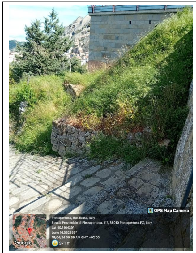
Int. e-3.1 Manutenzione Area Verde – Foto 1
